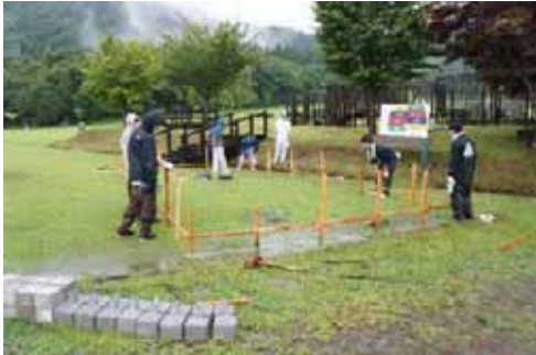
基礎の設置作業
