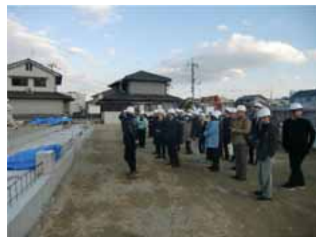
建設現場見学
