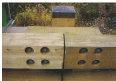
高欄部 補修前の状態
