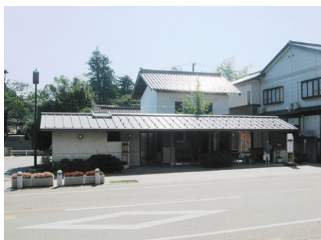
中央トイレ(平成7年)
