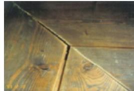
写真3 乾燥による床板の収縮 (高校体育館) *1
