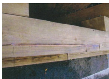
高欄部 埋木処理部
