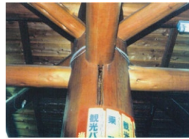
写真1 丸太背割りの開き (梁のほぞ幅より大きい) (ドライブイン) *1
