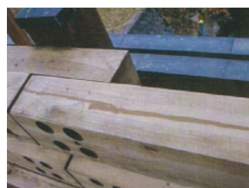
高欄部 コーキング処理部
