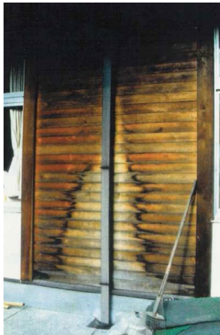
写真2 樋の破損による下見板の汚れ(保健センター)*1
