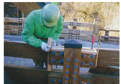
写真1 木橋高欄部の補修 *1 腐った部分をのみ等で除去し、心材に接着剤を塗布して端カネで心材を固定し補修している。
