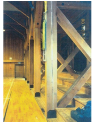
写真2 未乾燥ベイマツ材の柱に生じた大きな干割れ (高校体育館) *1
