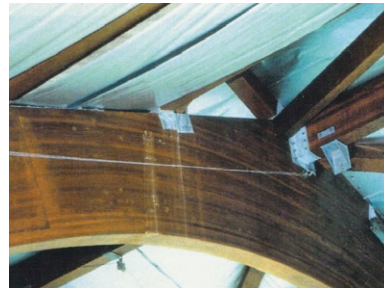
写真10 集成材接合部の金物の白錆(温水プール) *2
