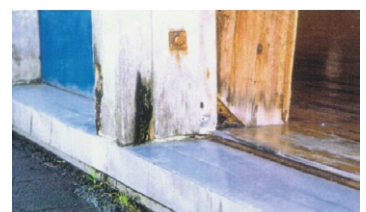
写真5 出入り口の柱脚部の変色、腐朽 (小学校体育館) *1
