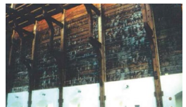
写真4 壁板からの雨水漏水による壁面の汚れ (高校多目的ホール) *1
