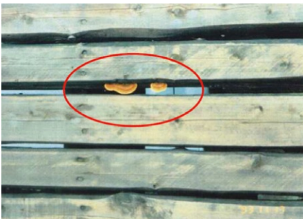
写真1 屋外バルコニーのヒノキ間伐材。木材保護塗料(キシラデコール)により塗装されていたが、効果がなくなりきのこが発生。*1
