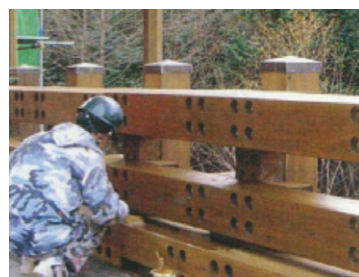
高欄部 第2回目塗装
