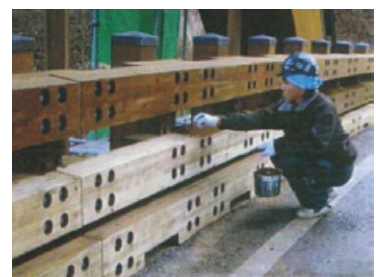
高欄部 第1回目塗装
