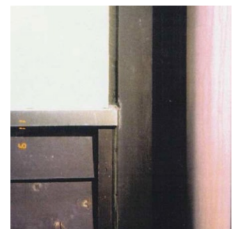
写真8 外壁とRC壁との境界面の隙間にコーキング充填(小学校) *1
