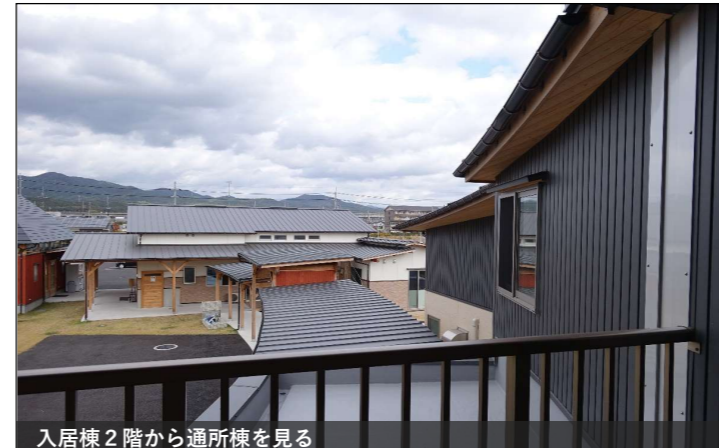
入居棟2階から通所棟を見る
