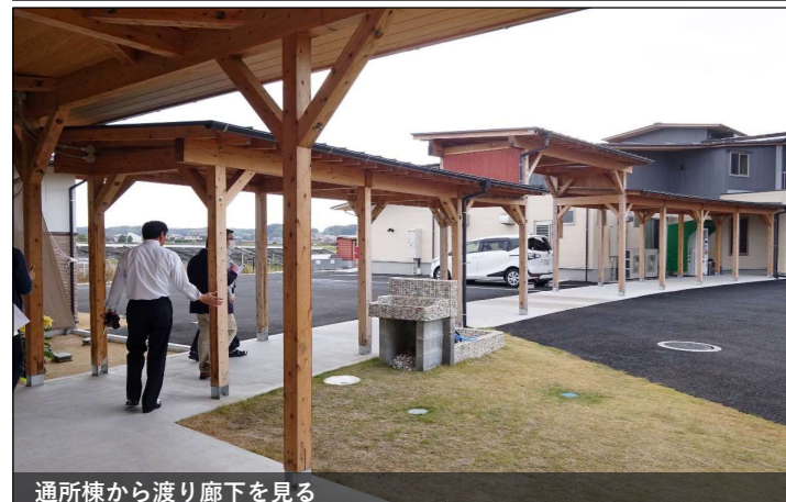
通所棟から渡り廊下を見る
