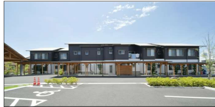
【A】駐車場から北棟を見る
