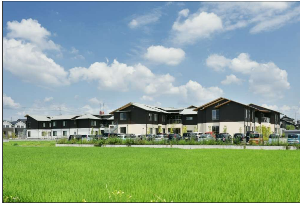
西側から西棟、北棟を見る
