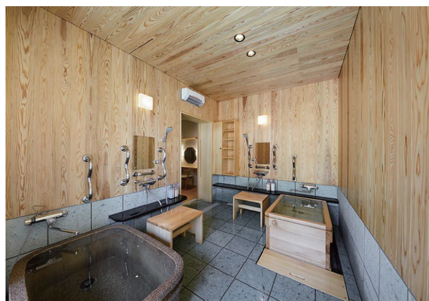
①浴室の床には濡れても滑りづらい十和田石を使用している
