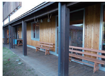
①雨の掛かりにくい縁側の板壁
