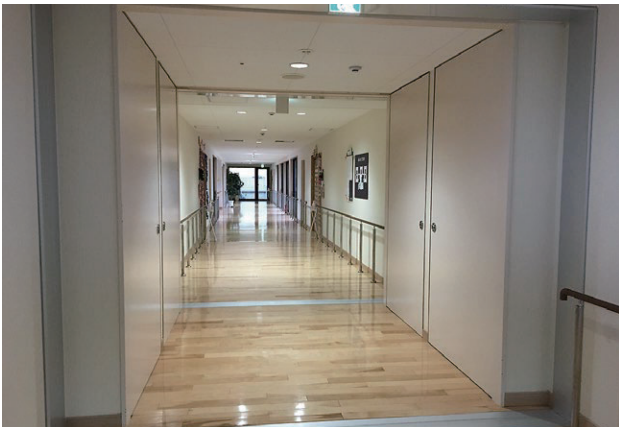
防火戸を設けた鉄筋コンクリート造の渡り廊下
