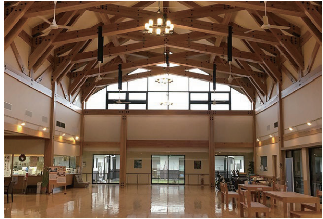
交流スペース(機能回復訓練室)の躯体は燃えしろ設計としている
