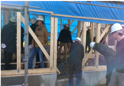
木造住宅の建設現場の見学
