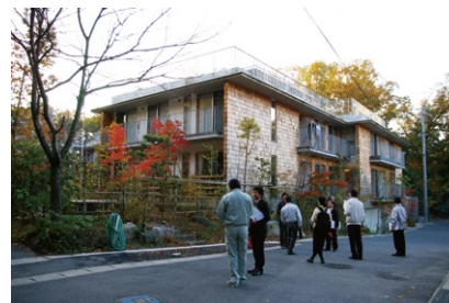
写真17 ウッドシングルによる外壁
