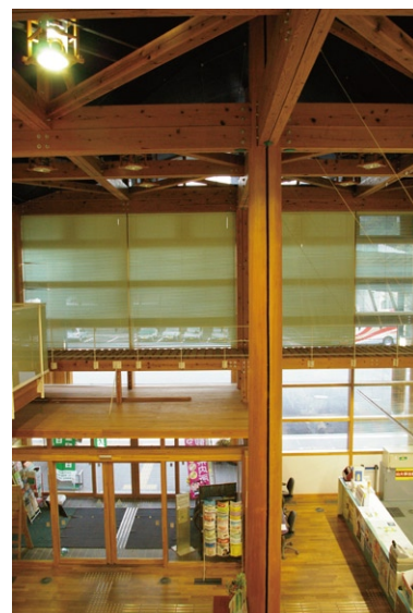
写真9 春野協働センター ガラス面の清掃のためキャットウォークを設置した。
