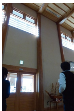
写真3 ホール吹き抜けに面したスギの通し柱
