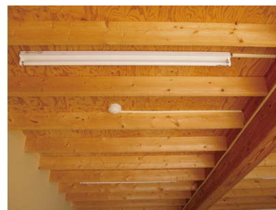
写真7 ケースウェイによる配線
