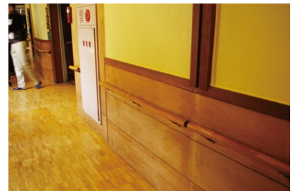
写真2 初期から内装木質化(腰壁:シナ合板、床:ナラ材(下地:合板+根太))を行っていた「ハモリーハウス」
