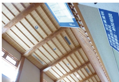
写真4 ホール吹き抜け上部のマツの大梁
