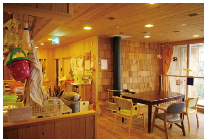
写真13 全面的に木質にすると単調になりがちであるが室内に外壁に使用したウッドシングル莖きを延長して使うなど工夫している
