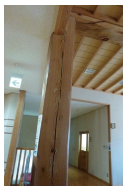
写真7 柱の割れ
