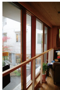
写真14 不燃木材の木製サッシ。開閉可能な部分以外にも手すりが設けられておりつかり立ちや移動を補助している
