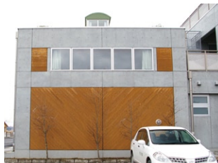
写真34 外壁木部の塗料落ち有り
