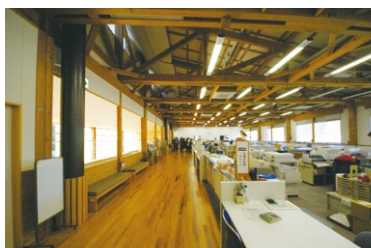
写真7 天竜区役所 足場を利用せずボルトの増し締めが可能
