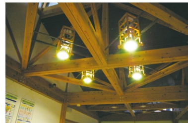
写真6 春野協働センター ボルトの増し締めが必要な部分
