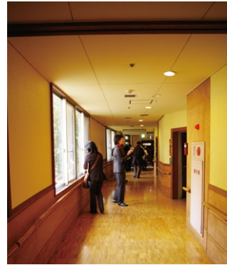
写真7 天井が低いことが排煙可能な窓として優位に働いた
