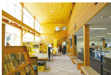
写真8 天竜区役所 吹き抜け空間に小屋組を見せずボルトの増し締めが必要が無いデザインとした。
