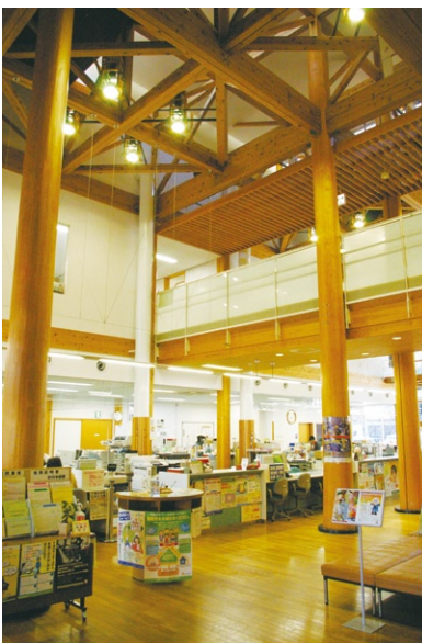
写真1 春野協働センター 意匠上のポイントに丸太柱を使用
