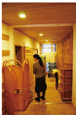
写真15 浴室前の防火設備
