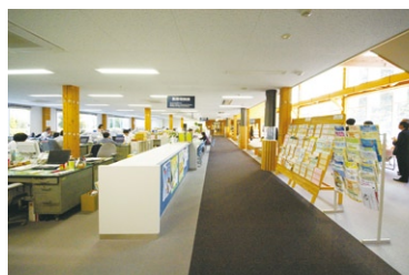
写真2 天竜区役所 130mm角の柱材4本をボルトで組み合わせた柱を使用
