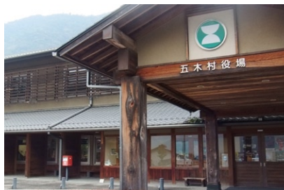
写真8 ポーチ独立屋根の柱
