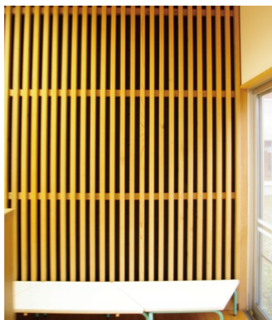
写真29 萩荘小:オープンスペースの防音対策
