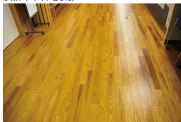
写真11 天竜区役所 圧縮木材のフローリング
