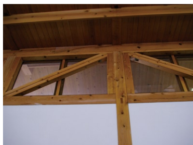
写真10 栄小:骨太の筋交いと柱の両側に付く添え柱
