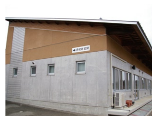
写真9 萩荘小:校舎(管理棟のブロック(RC造))
