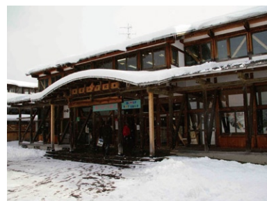
写真32 栄小:正面玄関の隅柱
