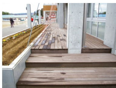
写真4 鶯沢小:ウッドデッキ
