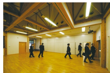
写真3 春野協働センター 下がってきた梁材
