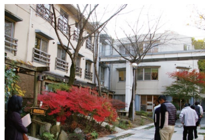
写真4 ハモリーハウス本館(右・アール部分・RC造)新館(プレキャストコンクリート造)
