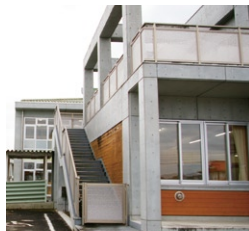
写真35 北西の外壁の隣に面する外壁は庇があり塗料の落ち無し
