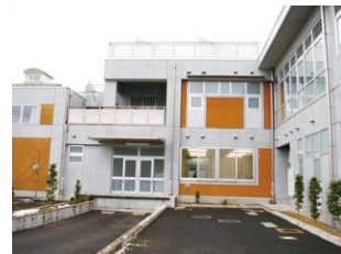
写真36 左側の外壁は軒の出があり塗料の落ち無し(卓越風の風下に当たる)
