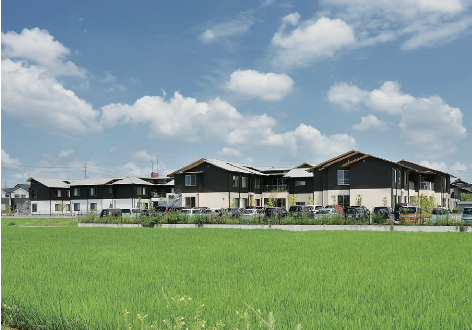
西側から西棟、北棟を見る
