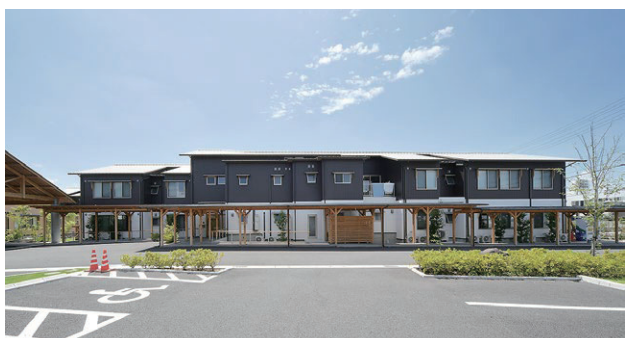
① 駐車場から北棟を見る
