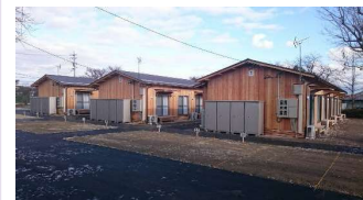
令和元年台風19号による被災地(長野県)で応急木造仮設住宅を建設
