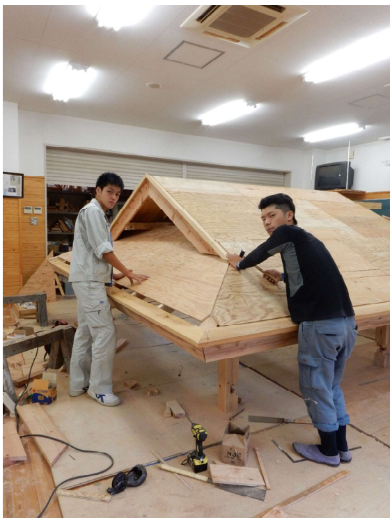
実技講習「建方・造作等の実習」(茨城県)
