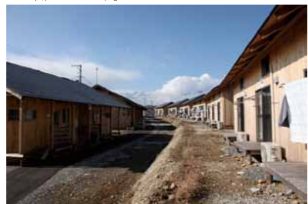
板倉構法による応急仮設住宅
