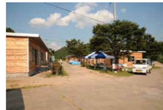
写真1 公園に建設された木造仮設住宅
