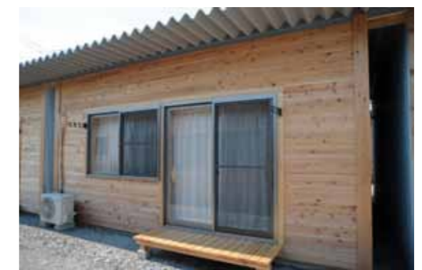
写真2 完成した木造仮設住宅
