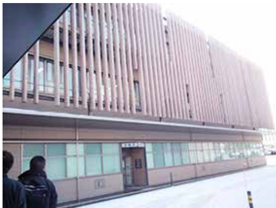
写真1 総合福祉保健センター
