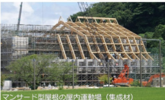
マンワード型屋根の屋内運動場（集成材）
