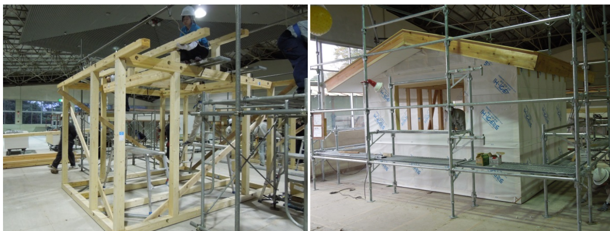
図6-3-7 木造実習の訓練用モデル（富士KKCにおける別コースでの実習）
