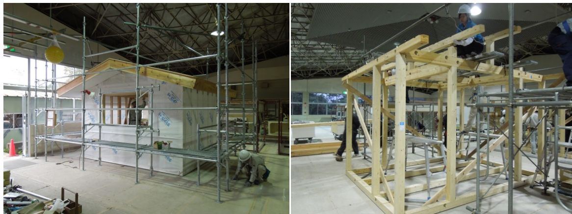
図 7-3-1 6 帖平屋実習モデル（左：軸組、右：下地・透湿防水シート・軒仕舞・ルーフィング等）
