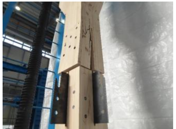
写真11 破壊状況 試験体番号：中間階4
