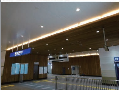
東武日光線幸手駅東西自由通路
