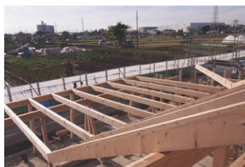
写真7 吊梁のセット
