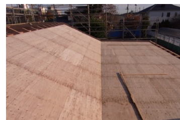
写真8 構造用合板による折板
