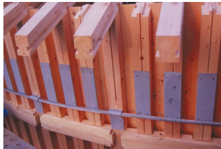
写真28 タガ締めのカابل
