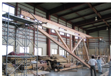
写真17 二重合成梁モックアップ
