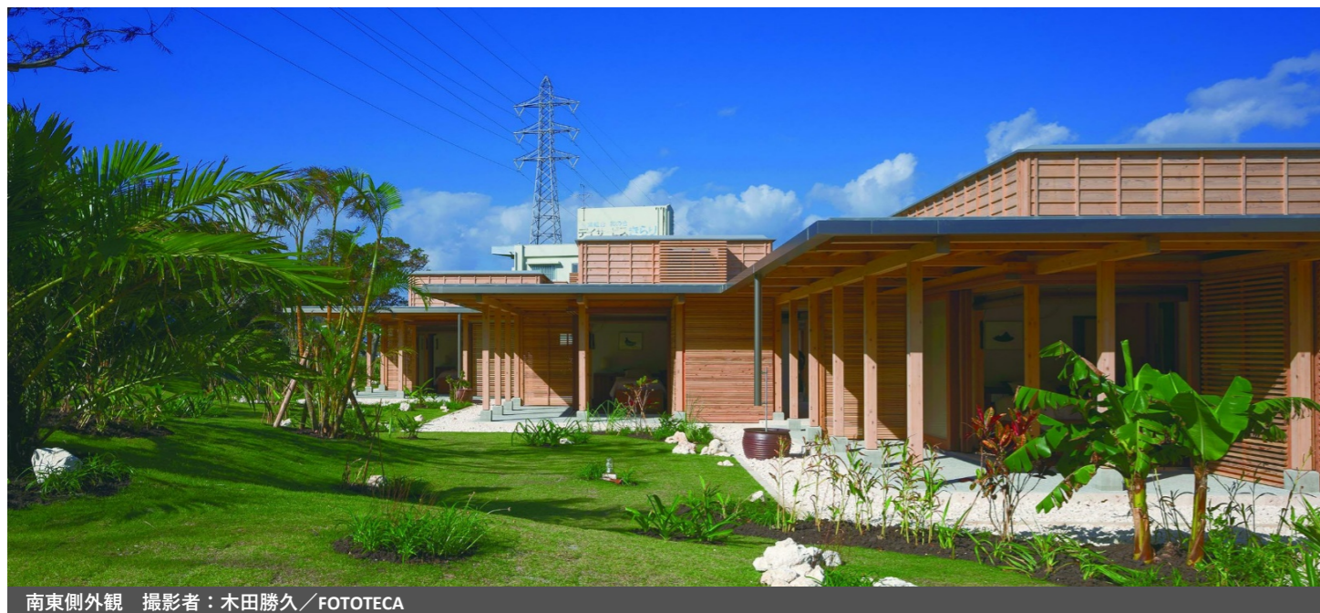
南東側外観 撮影者：木田勝久/FOTOTECA
