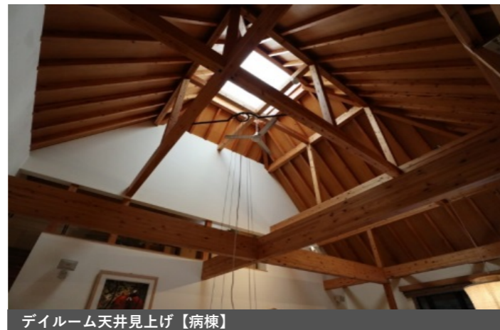
デイルーム天井見上げ【病棟】
