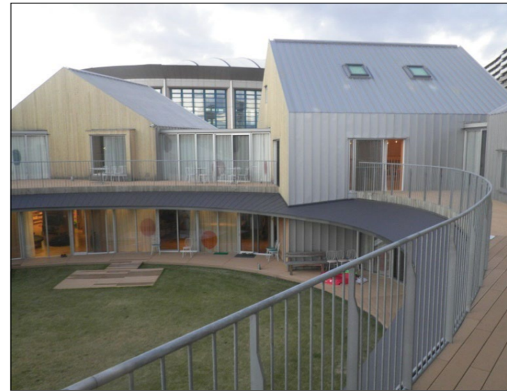
中庭より北側を見る
