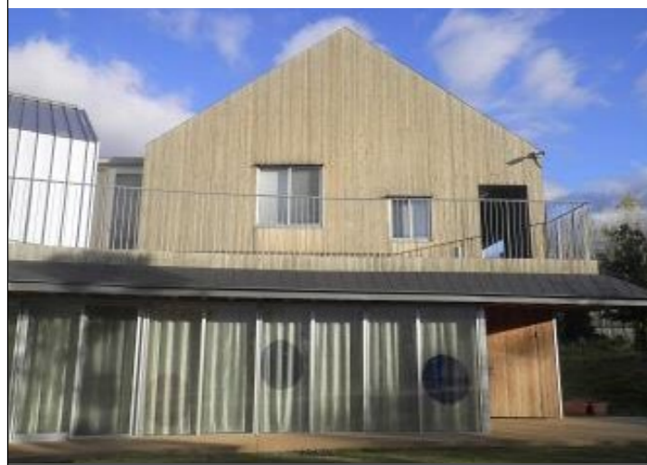
中庭より東側を見る
