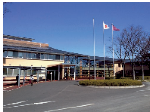
写真2 宮代町役場外観（耐火構造で木造を分棟化し耐火要件を緩和）
