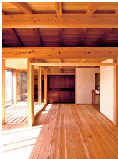
写真3 製材の柱・はりの燃えしろ設計
