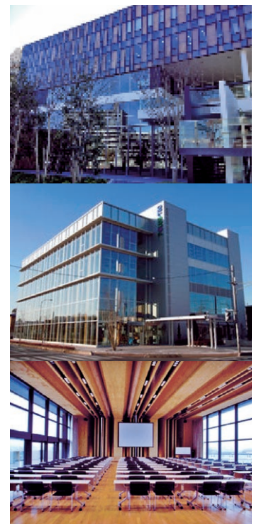
写真1～3 木造耐火建築物の事例（上から写真1）
