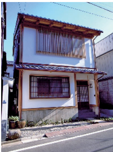
写真2 木造準耐火建築物の事例
