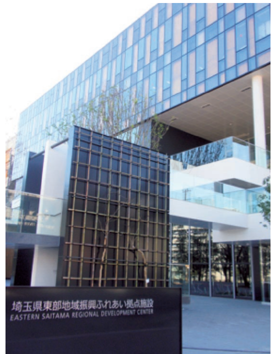
写真2 6階建ての5～6階を木造とした事例
