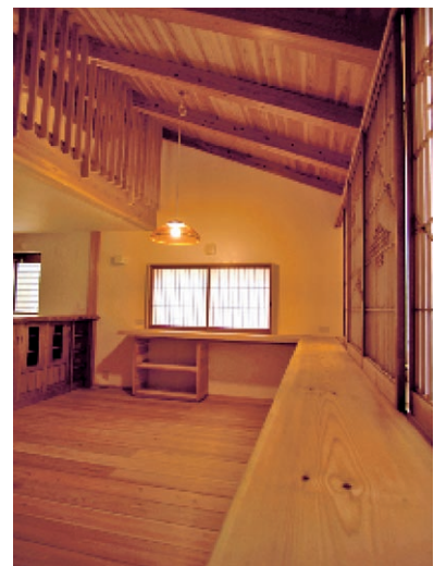
写真4 内装制限新告示の適用例 (天井木材)
