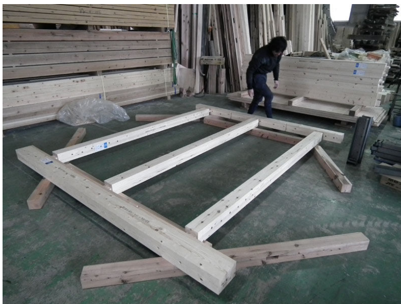
写真7 耐力壁軸部材の組立
