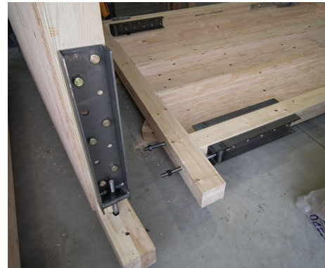
柱脚部への取り付け
