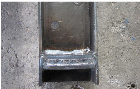
アンカーボルト受け座部分の変形
