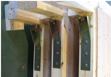
柱頭部への取り付け
