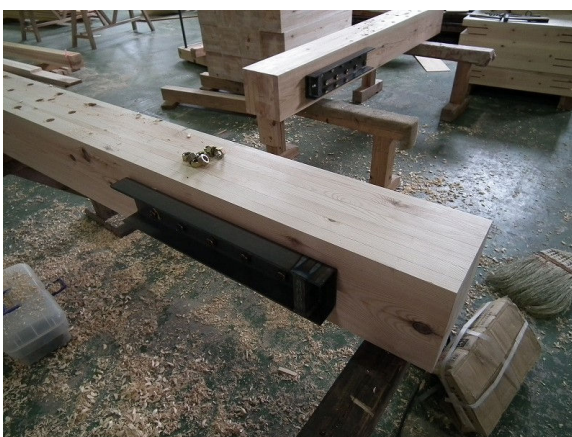
柱への HD 金物の取り付け
