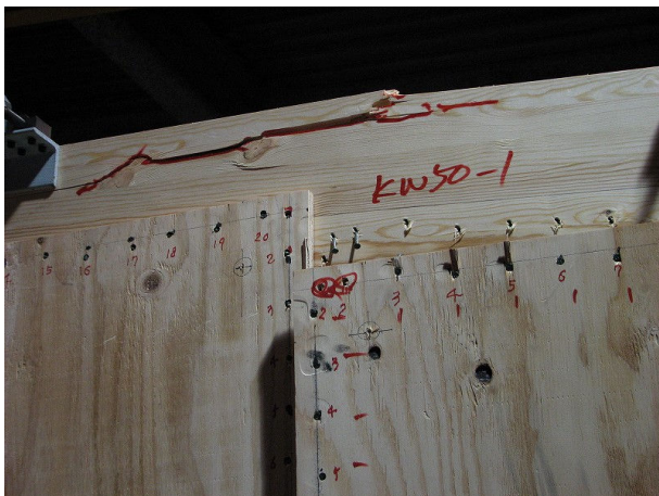
合板・12両-CN50-50の梁の曲げ破壊
