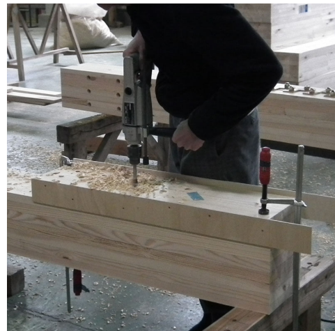
治具を用いた穴あけ作業
