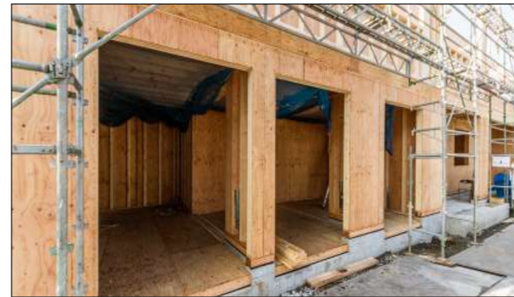
建て方等の木造躯体（1階）
