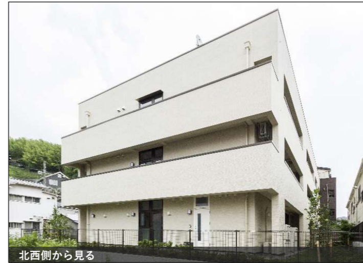
北西側から見る
