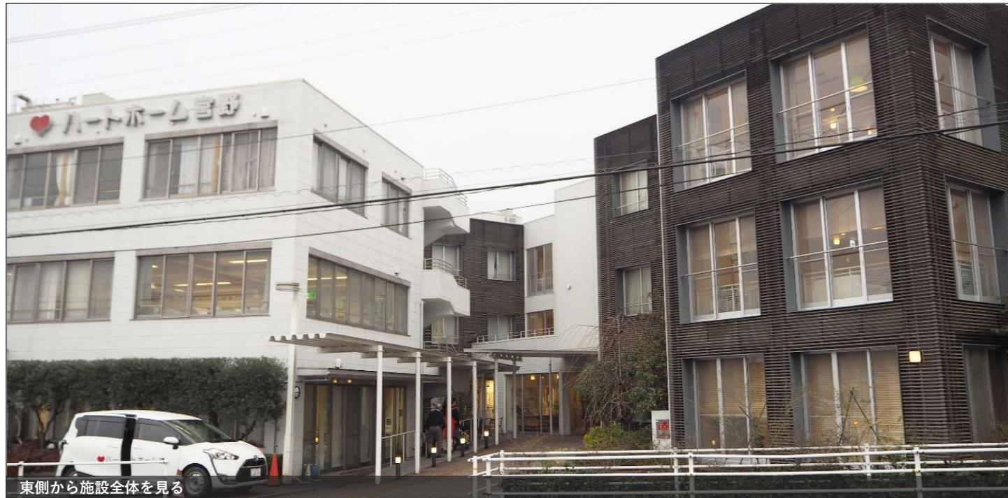
東側から施設全体を見る
