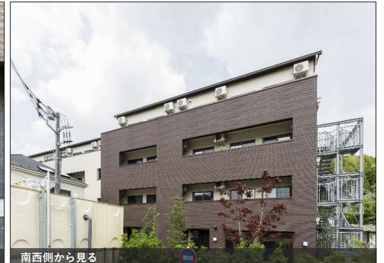
南西側から見る
