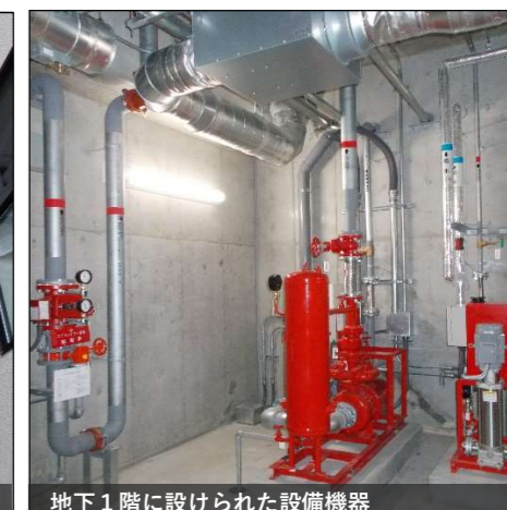
地下1階に設けられた設備機器
