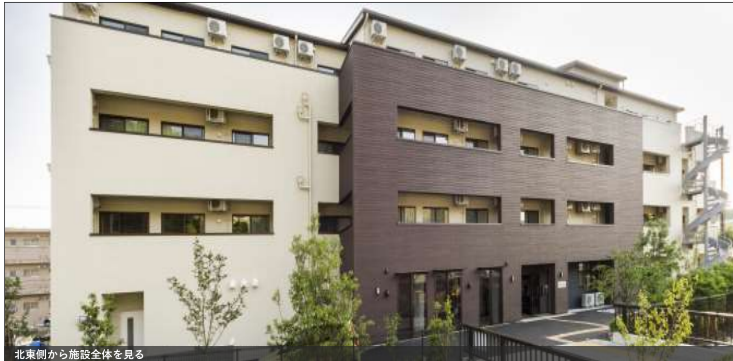
北東側から施設全体を見る
