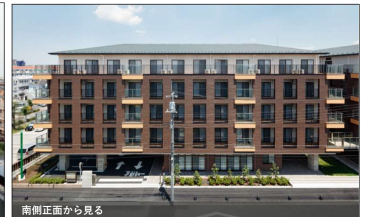
南側正面から見る
