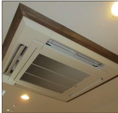
天井カセット型エアコンの木枠
