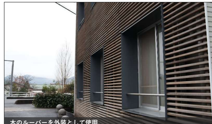
木のルーバーを外装として使用
