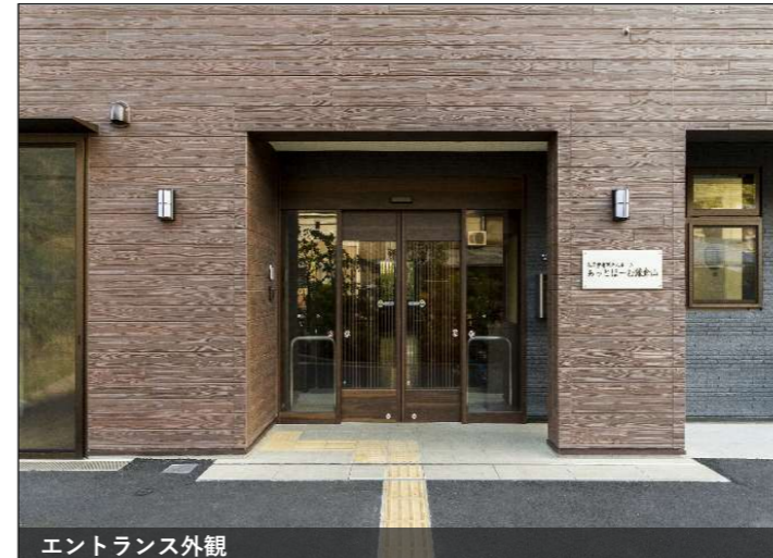
エントランス外観
