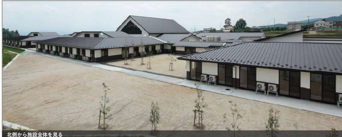
北側から施設全体を見る
