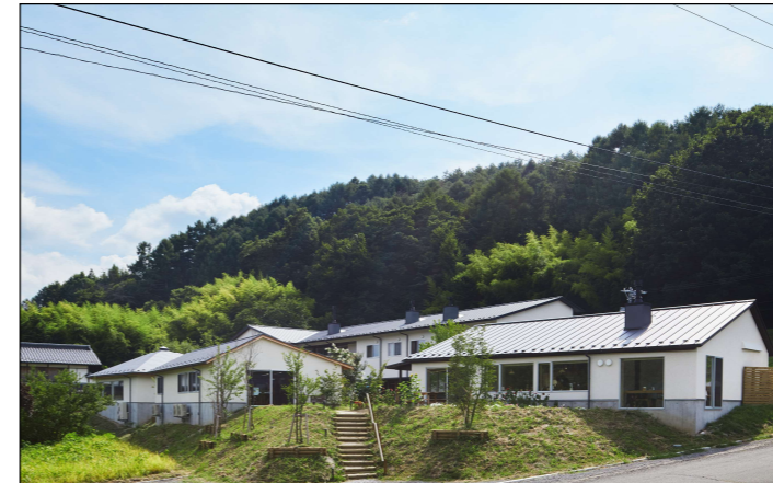
施設東側の地域の通りぬけ道路から全体を見る
