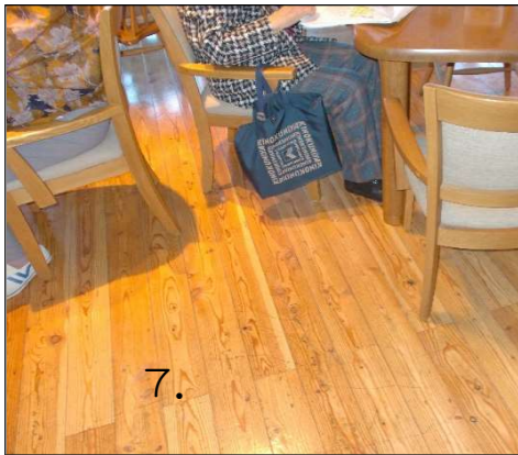
【A】1階の食堂兼機能訓練室フローリング 写真撮影：現代計画研究所
