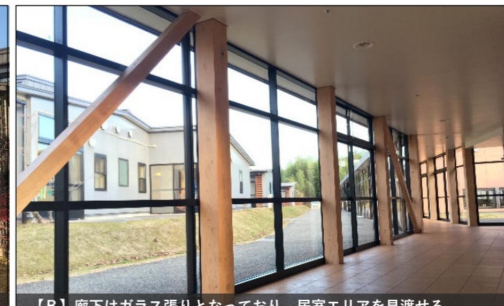
【B】廊下はガラス張りとなっており、居室エリアを見渡せる
