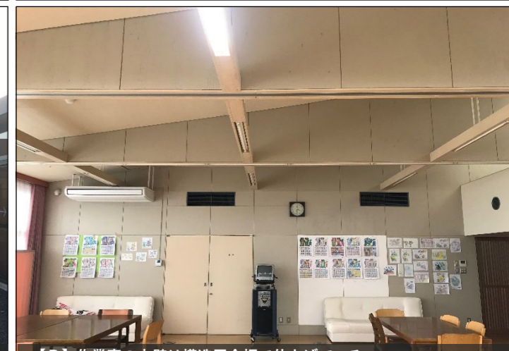
【B】作業室の内壁は構造用合板で仕上げている
