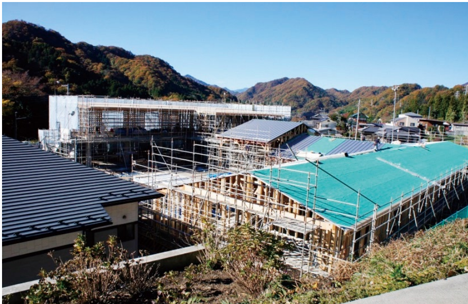
写真1 工事中の外観(手前がA棟、奥にB棟。A棟には保育室と地域開放用の会議室を配置している。B棟は2階に遊戯室があり、その下が屋根付き駐車場(ピロティ)となっている。)
