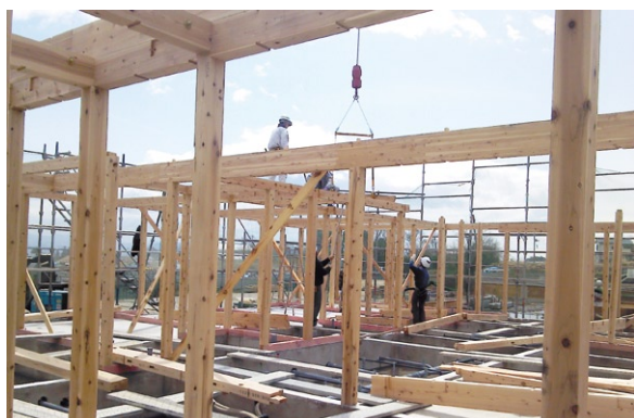
写真5 北棟の建て方
