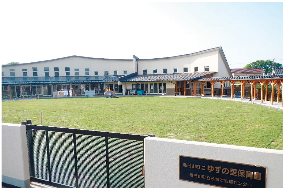
写真2 全景 (中央に防火壁)
