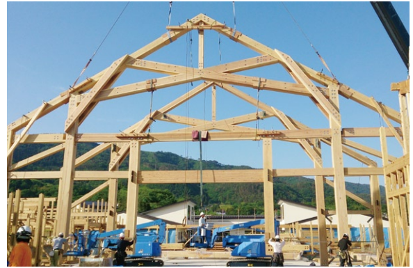
写真8 交流スペース建て方
