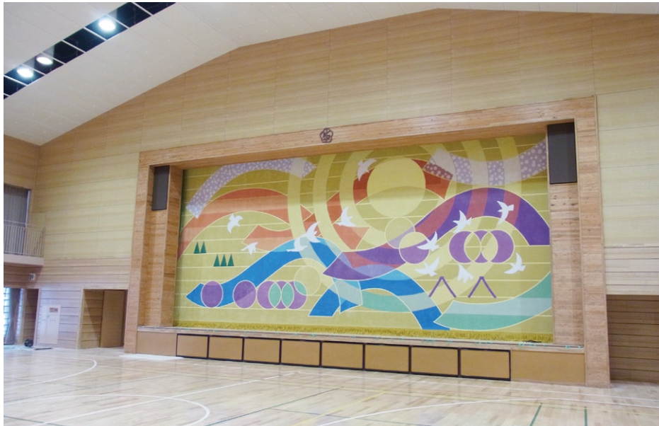
写真5 体育館プロセニウム(スギ板貼り)
