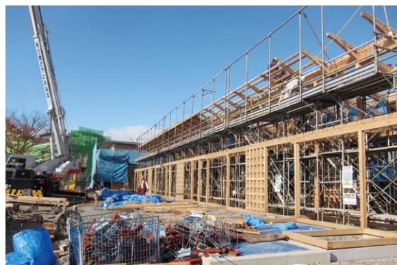
写真3 三重桁の建て方の様子 右端にクレーンにて吊り上げ中の地組済みのユニットが見える
