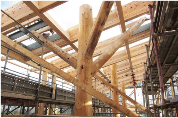
写真4 建て方の様子
