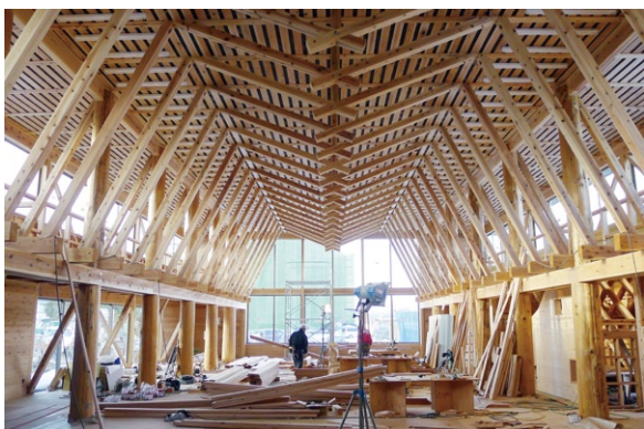
写真2 遊戯室の架構
