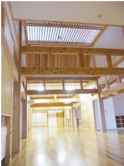
写真1 校舎棟2階トップライト部杉板貼+ルーバー
