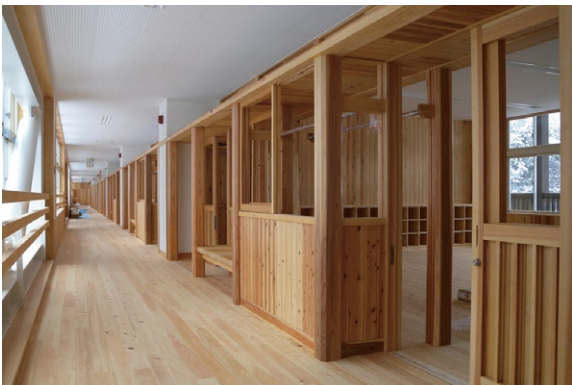
写真5 既存RC造・内装木質化 間仕切り(施工中)
