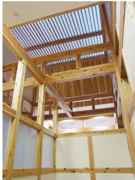
写真2 校舎棟階段からトップライトを見上げる
