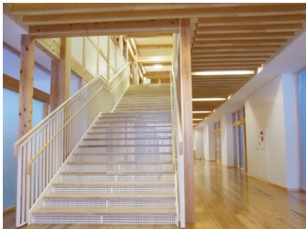
写真3 校舎棟階段から2階木軸フレームを見る(階段踏み板には集成材を使用している。)
