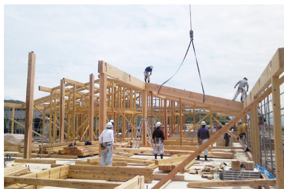
写真6 デイサービス部分の建て方
