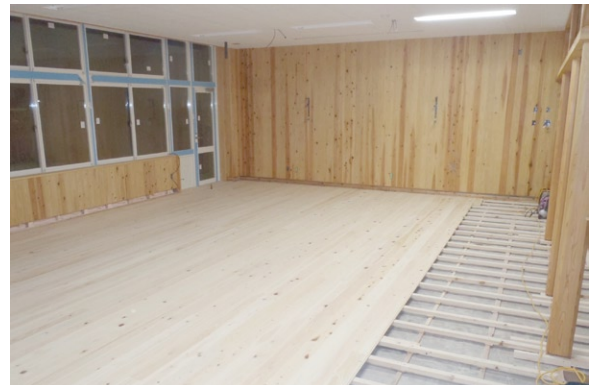
写真4 既存RC造・内装木質化 フローリング(施工中)
