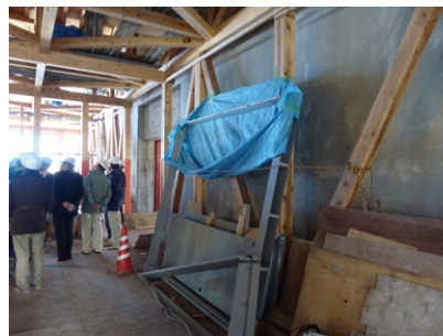
写真3 防火壁(2階内部)
