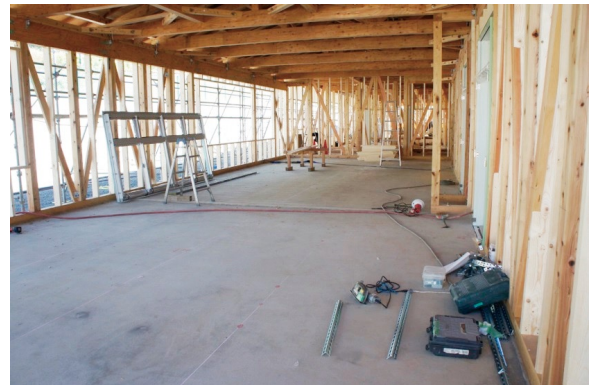
写真5 地域開放用の会議室(防火被覆する前)
