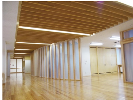
写真4 校舎棟1階廊下天井ルーバー、150角柱間仕切
