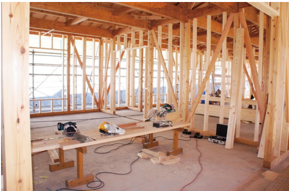
写真4 保育室(防火被覆する前)
