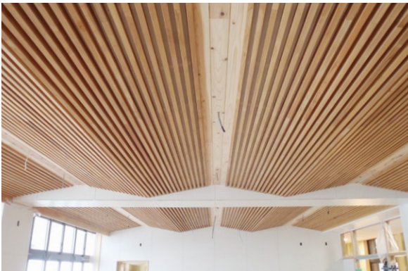
写真3 既存RC造・内装木質化 天井(施工中)
