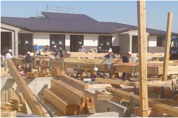
写真7 交流スペースの架構の地組風景(奥に既に外観まで整い始めている北棟が見える)
