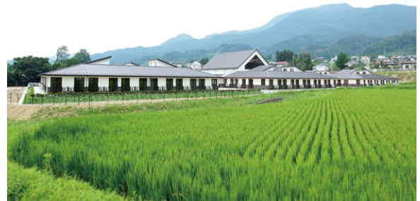
写真2 北側外観(居住エリア側) 奥に交流スペースの大屋根が見える
