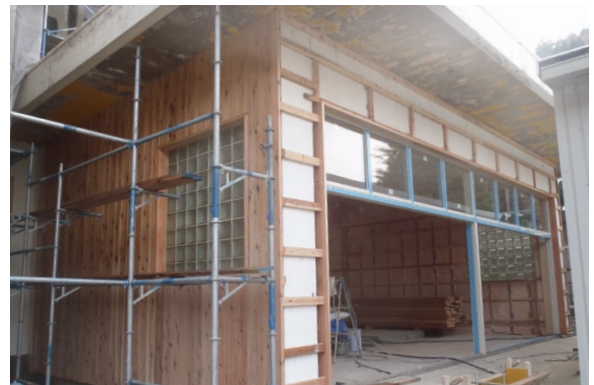
写真6 既存RC造・外壁の木質化(施工中)
