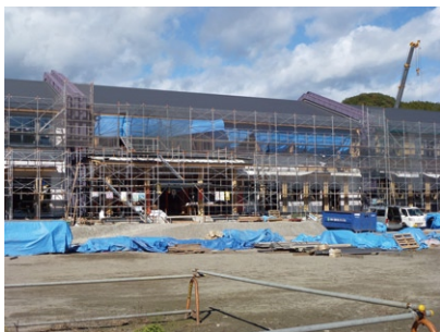
写真2 防火壁(屋根から出ている部分)
