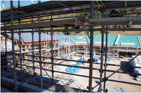
写真2 B棟2階遊戯室よりA棟をみる
