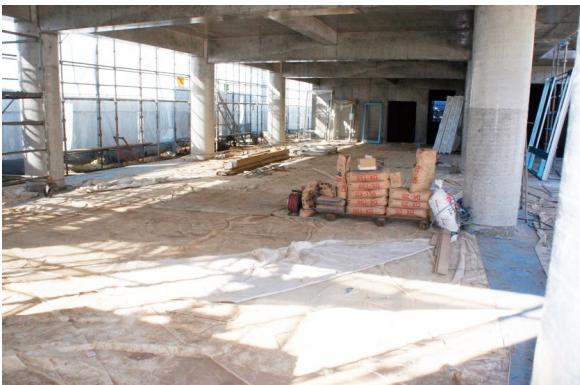
写真6 ピロティ(屋根付き駐車場)
