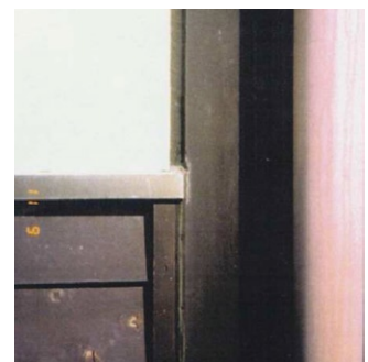
写真8 外壁とRC壁との境界面の隙間にコーキング充填(小学校) *1
