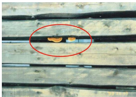
写真1 屋外バルコニーのヒノキ間伐材。木材保護塗料(キシラデコール)により塗装されていたが、効果がなくなりきのこが発生。 *1
