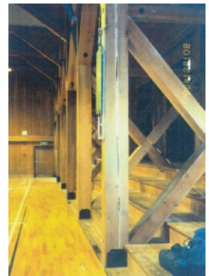
写真2 未乾燥ベイマツ材の 柱に生じた大きな干割れ (高校体育館) *1
