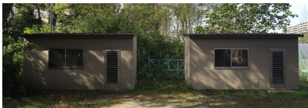
図 1. 実験棟外観 A 棟 (左)、B 棟 (右)
