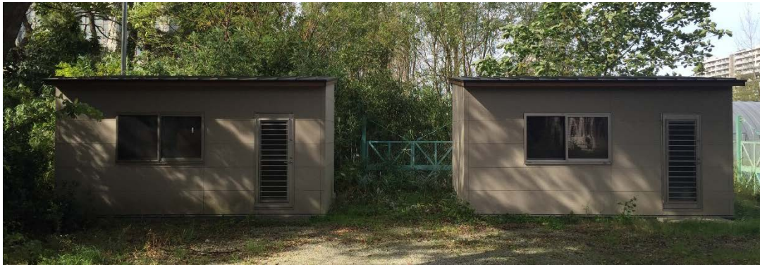
図1. 実験棟外観 A棟(左)、B棟(右)
