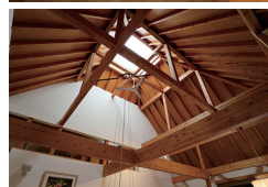
デイルーム天井見上げ
