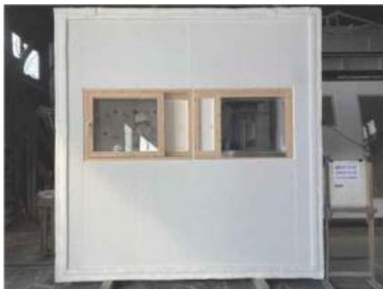
写真 6. 2-25 加熱面の様子 (左：屋内側, 右：屋外側)
