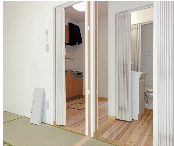
写真-14 一般住戸内の段差解消
