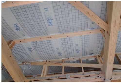
写真 5：セルロースファイバー（断熱材）を充填した屋根断熱
