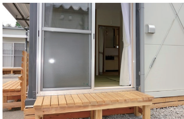
写真-5 掃出し窓とぬれ縁(プレハブ仮設住宅)
