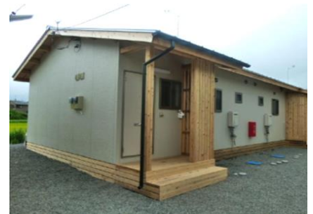
熊本広域大水害時に建設した 木造応急仮設住宅
