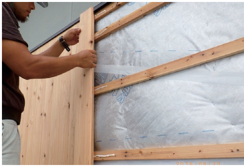
写真 6：外壁の杉板張り
