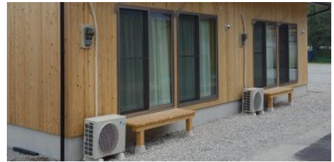
掃出し窓・濡れ縁
