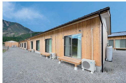
写真 9：濡れ縁と開口部上部の物干し
