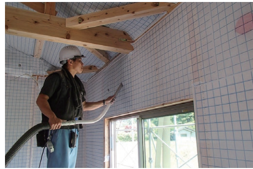
写真 7：セルロースファイバー（断熱材）の充填
