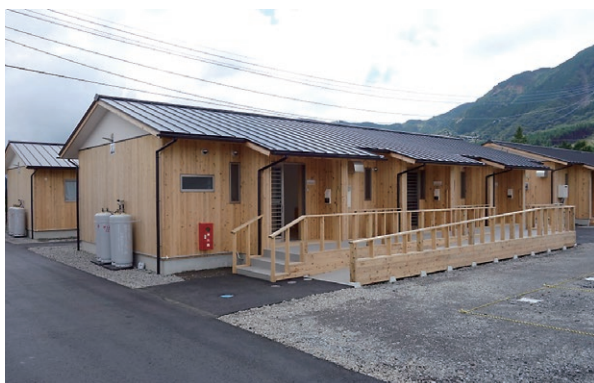
写真-4 スロープを設けた木造仮設住宅
