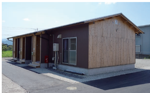
写真-7 木造仮設住宅（建築士会・木と住まい）
