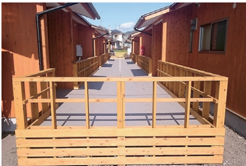
写真 20：住棟間のデッキ
