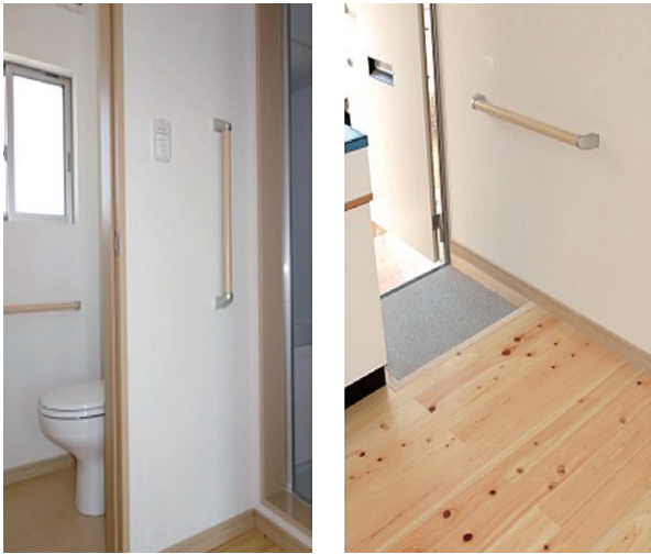
写真-13 一般住戸内の手すりの設置
