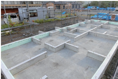
写真 1: 間仕切りにも基礎立ち上がり設置
