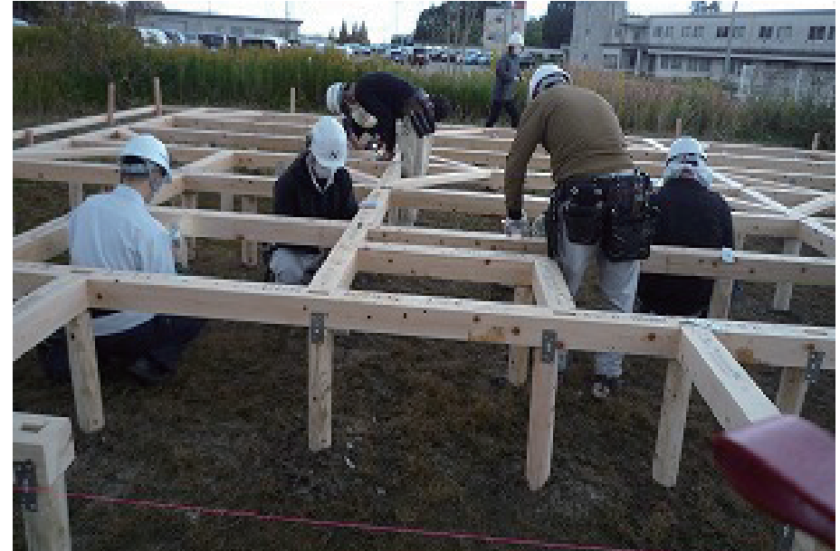
木造応急仮設住宅実習訓練研修会(木杭編) 富山県
