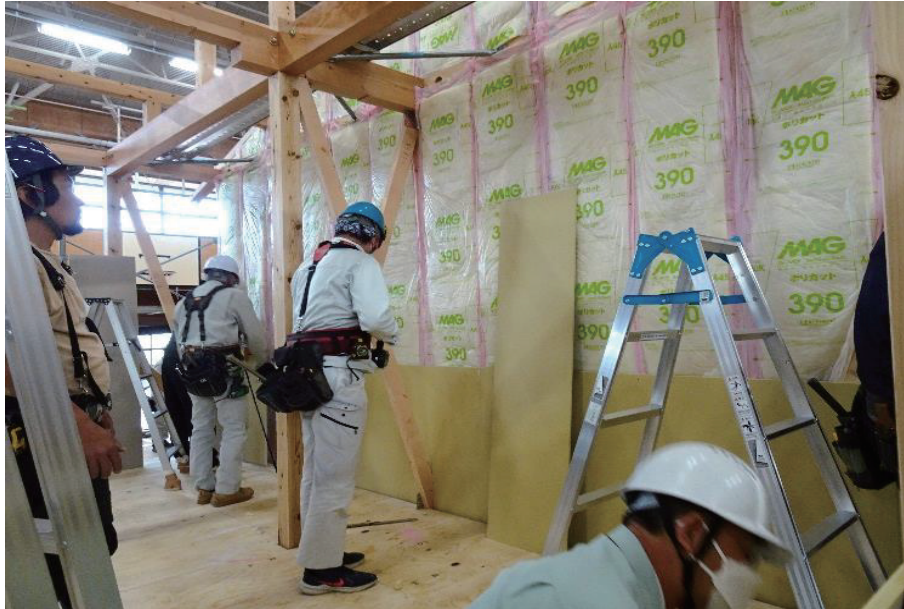
木造応急仮設住宅実習訓練研修会(界壁施工編) 群馬県
