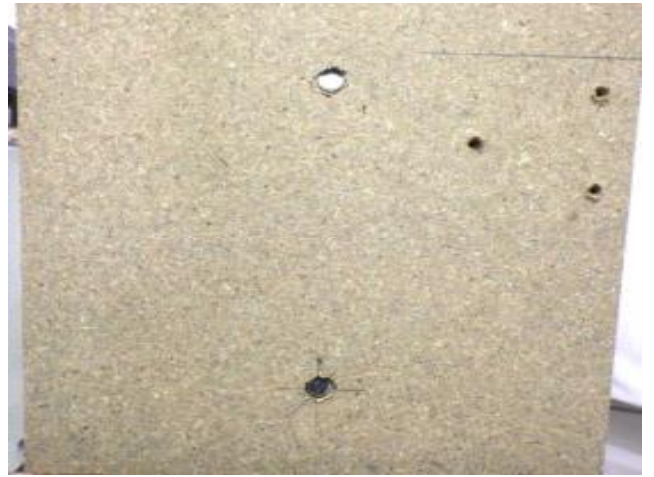
写真-9 Sd-3「試験終了後」
