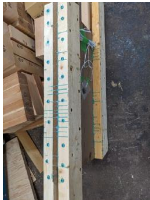
図 5.2 割裂補強ビス施工状況
