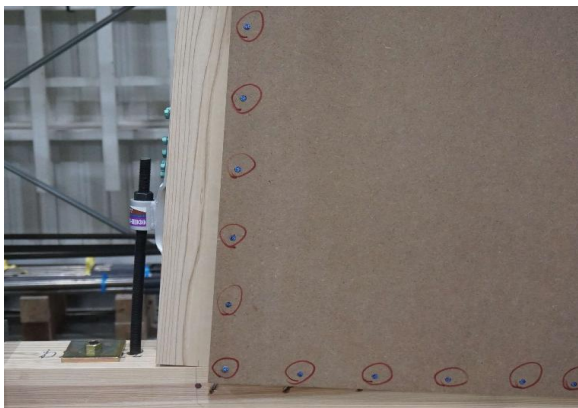
くぎの引抜け
