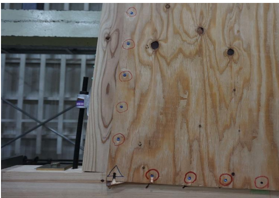
面材の縁切れ、くぎの引抜け
