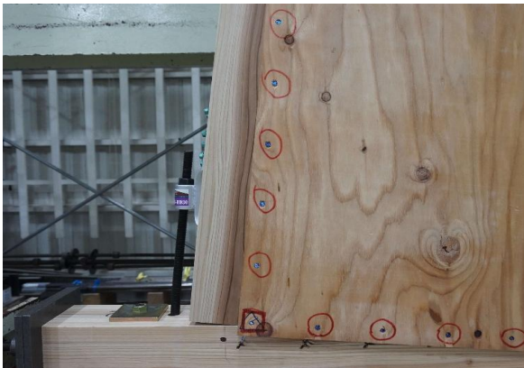
くぎの引抜け
