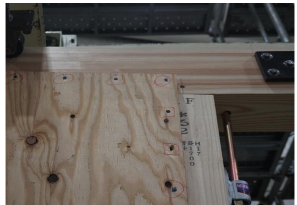
くぎの引抜け
