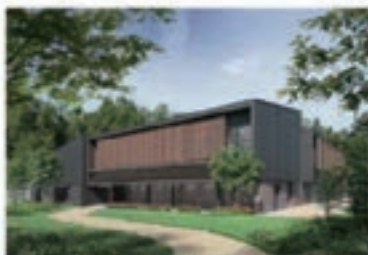
CLT ユニット工法による準耐火木造ホテル 階数：地上2階 構造：混構造 規模：2,549 m 2
