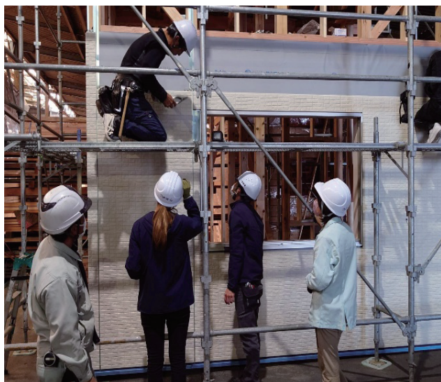
外部施工 胴縁取付け、サイディング張り
