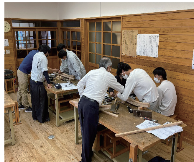
加工作業(土台・桁・柱)
