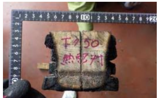
写真 5. 3. 2-16 柱下端から 750mm (熱電対設置位置／見上げ)
