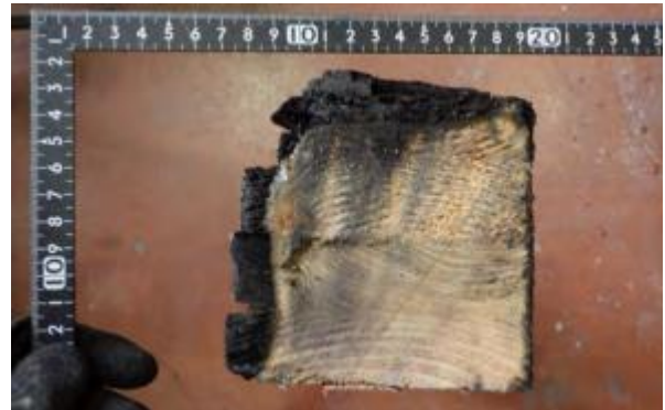
写真 5. 3. 2-34 柱下端から 750mm (熱電対設置位置／見上げ)
