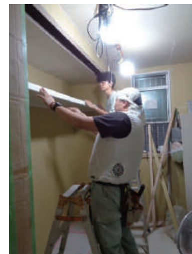
枕棚施工 指導
