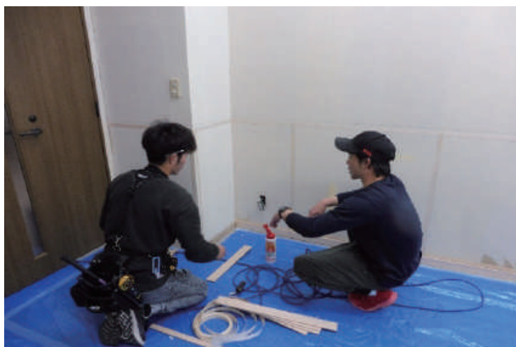
長期・集中訓練 2023年11月7日 全建愛知 Lv1(実技) 会議室の腰板施工研修
