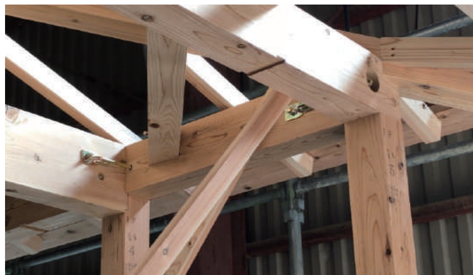
プレカット材を活用した建て方
