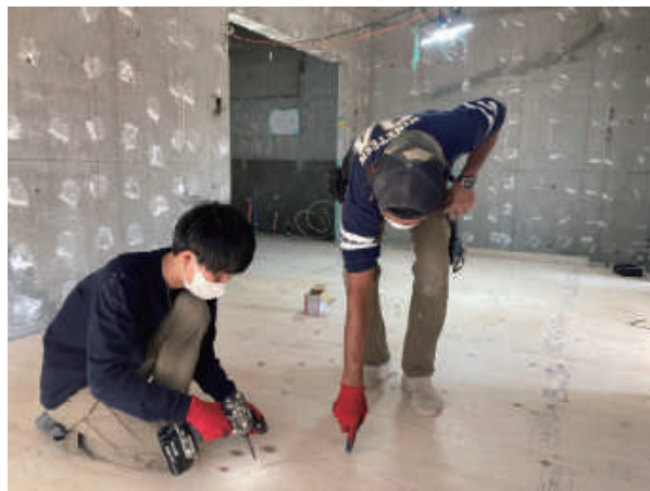
床施合板施工 指導
