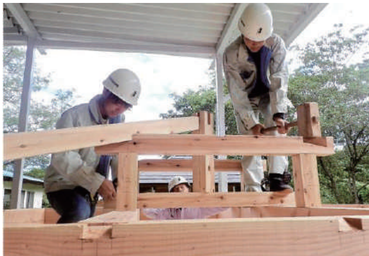
長期・集中訓練 2023年10月22日 茨城県連(日立) Lv1(実技) 方形屋根施工実習
