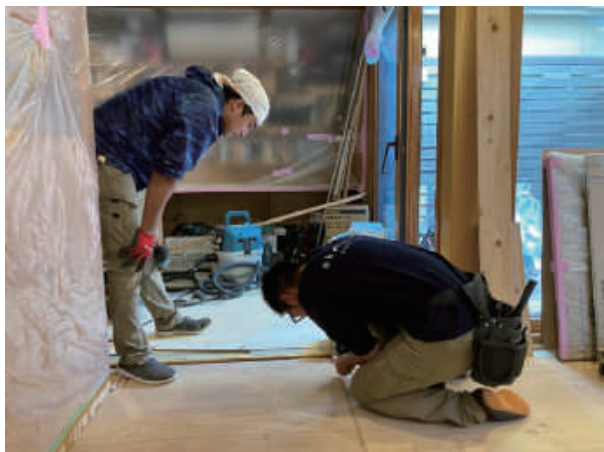
床施合板施工 指導
