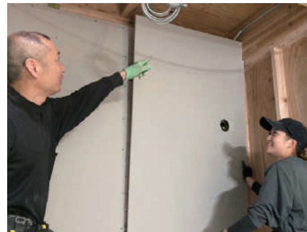
ボード施工 指導
