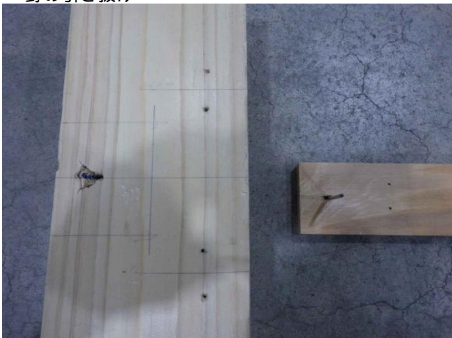
写真 -49 「C _Wk_1_180_30_N 解体後」
