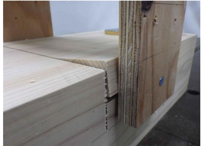
写真 -11 「C _Wk_1_180_30 試験終了後」
