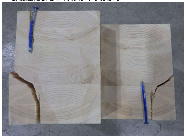
写真 -40 「C _Wk_4_180_2040 解体後」
