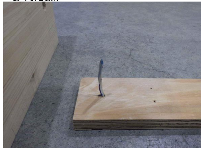
写真 -50 「C _Wk_1_180_30_N 解体後」
