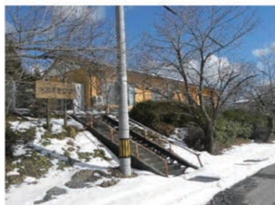
南側道路より遠景
