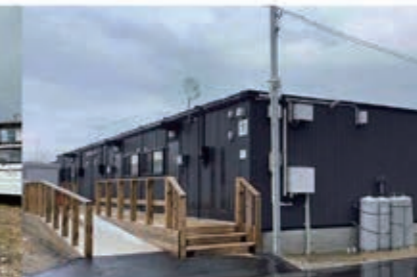
ウッドデッキスロープ
