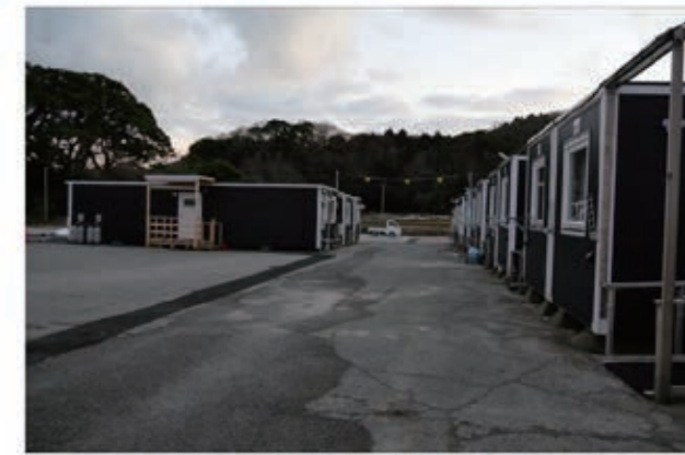
北側より団地内通路(右:1号棟、左:2号棟)
