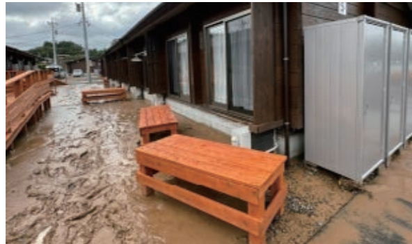
応急仮設住宅の被災状況（山岸町第3団地（輪島市））
