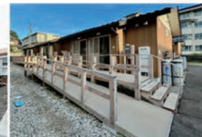
平屋建ての北側玄関側
