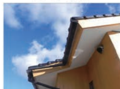
J形瓦・破風・鼻隠し・縦羽目板
