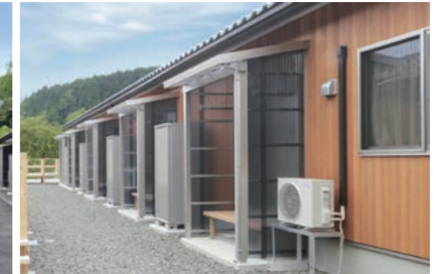
写真6 アルミ製のデッキ屋根
