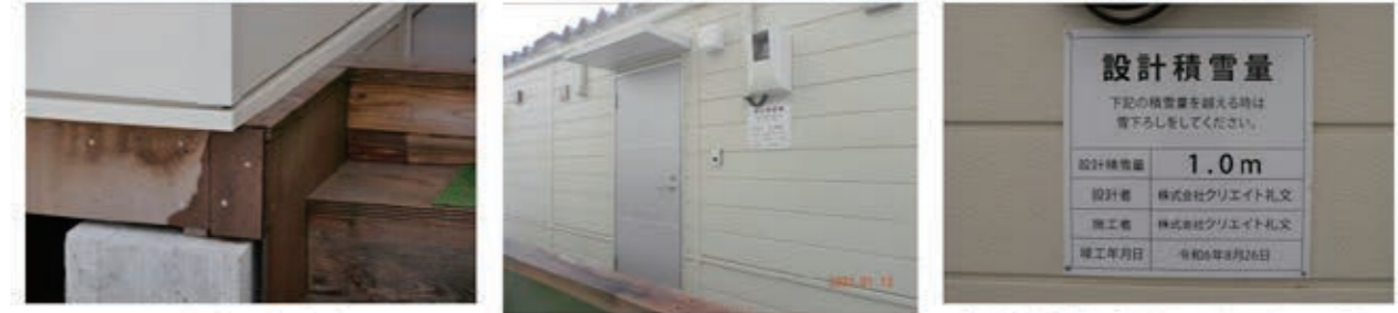
土台・ウッドデッキ
