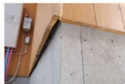
縦羽目板・RC基礎
