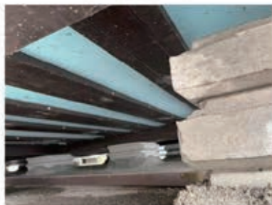
基礎および土台
