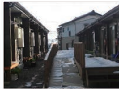
住棟の間(西側より)
