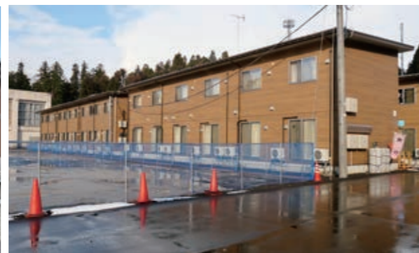
写真4 2階建て(長屋型)住棟
