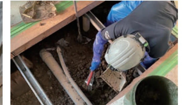
床下の泥撤去
