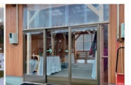
コモンにセルフビルの建具設置
