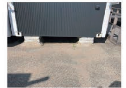
PC架台(舗装面上)
