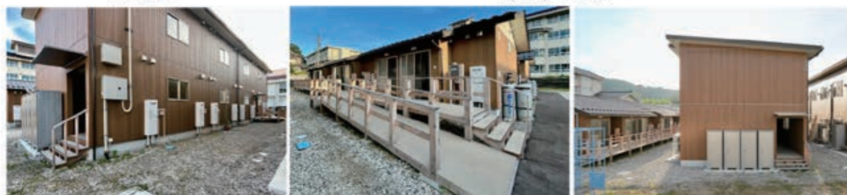
北側廊下への入り口 平屋建ての北側玄関側 2階建ての妻面
