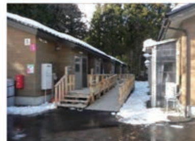
4~5号棟間、デッキ・玄関側(5号棟東側)
