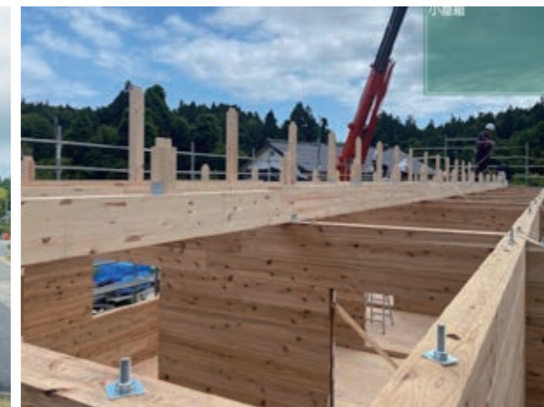
珠洲市三崎町第4団地 建て方 妻壁、小屋は軸組構法
