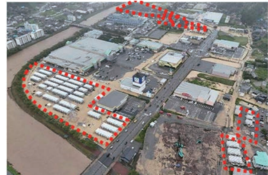
輪島市街地における被災状況(点線: 応急仮設住宅)
