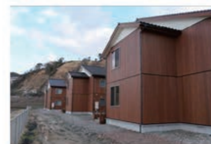
海側(北側)より全景
