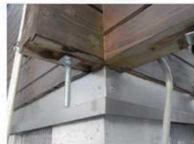
基礎・床下換気口・セリング用ボルト
