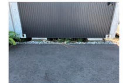
PC架台(舗装面上)
