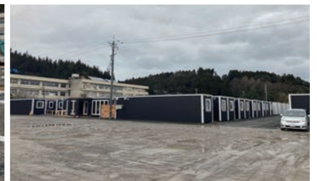
写真4 正院町第1団地(第一期)完成時
