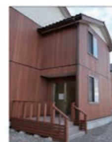
エントランス・階段室・内廊下へ
