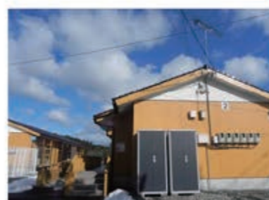
住棟の間・南側妻面
