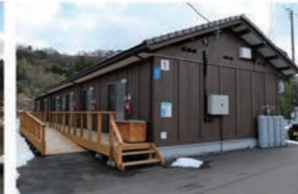
玄関側(北側)・西側妻面
