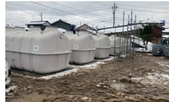
写真5 浄化槽施工中の様子
