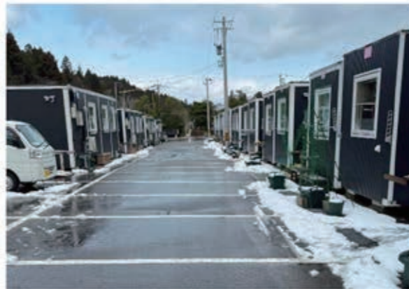
全景(第1棟、第2棟)
