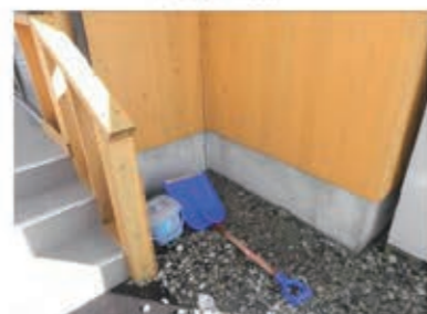
縦羽目板・RC基礎
