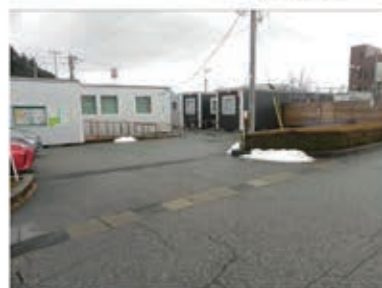
団地入口(西側)より外観遠景
