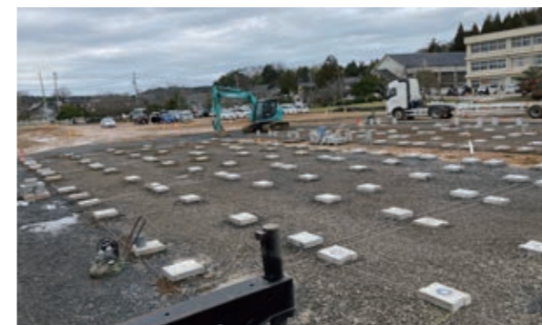
写真3 工事初期基礎平板敷き
