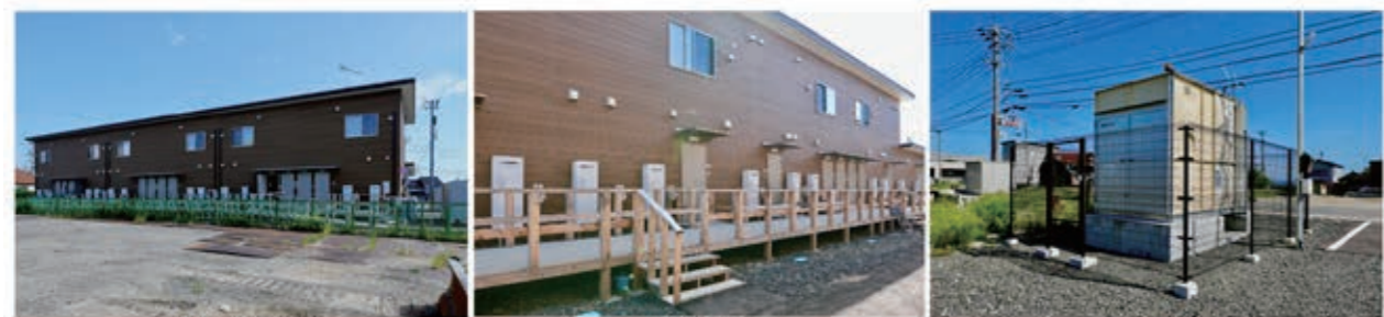
北側隣地より
