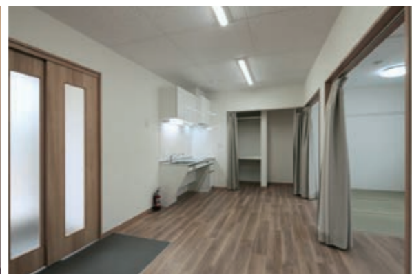
写真11 バリアフリータイプの台所
