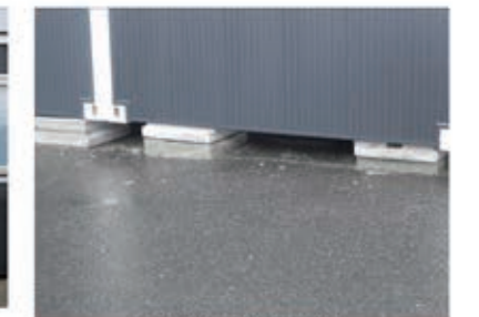
PC 架台 (舗装面上)
