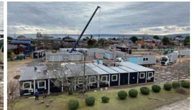
写真6 ムービングハウス吊りこみの様子
