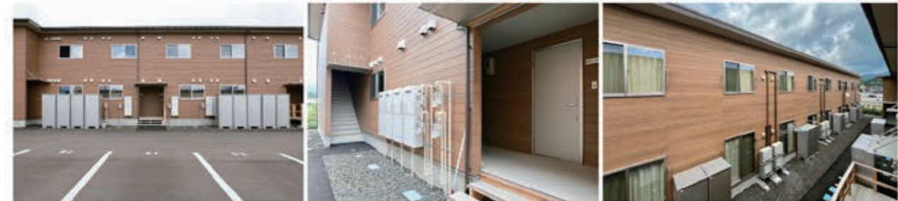
北側駐車場より
