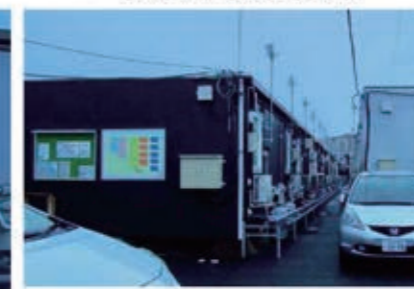
背面に室内機ほか機器がならぶ
