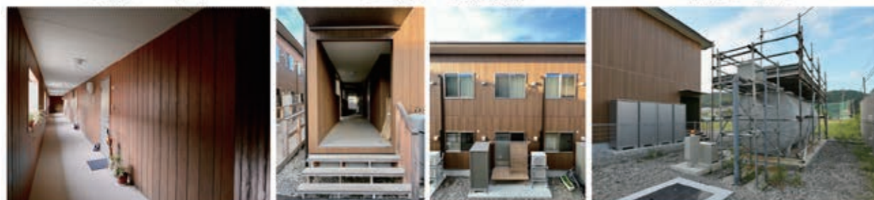
2階廊下 1階廊下 2階建ての南面 浄化槽
