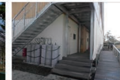
玄関側(外廊下・外階段)
