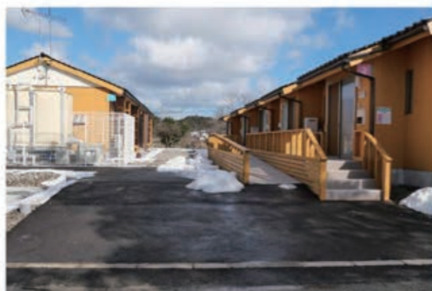
南側より全景
