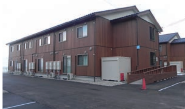
写真1 大谷町第1団地（鉄筋コンクリート基礎）
