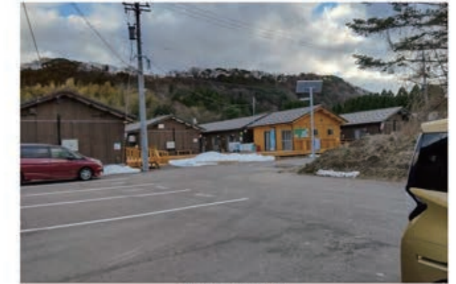
北西側より全景
