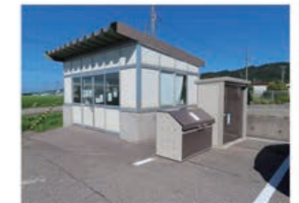
談話室(既存鉄骨建物)とごみ置き場
