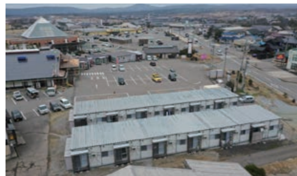
写真7 とぎ第3団地（道の駅）
