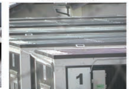
屋根 舟勾配の折板葺き
