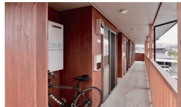
解放的な共用廊下 杉平町第3団地
