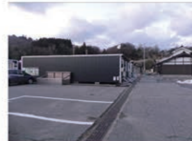
2号棟と道の駅の建物(南側より)
