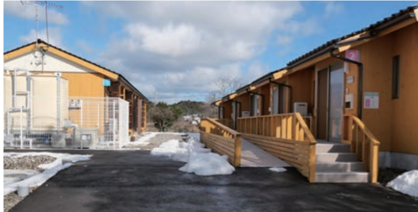
上戸町第3団地（珠洲市）
