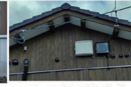
F形瓦・けらば側母屋露出・縦ログ
