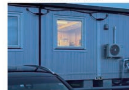
内部は木質化されている
