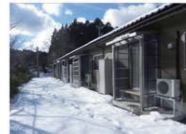
窓側(1号棟南側)
