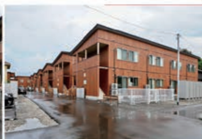
南側駐車場より
