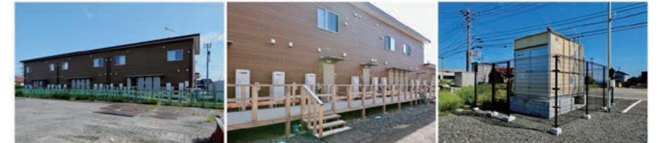
北側隣地より
