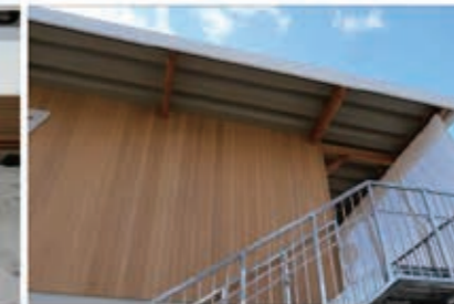
片流れ屋根 折板葺き
