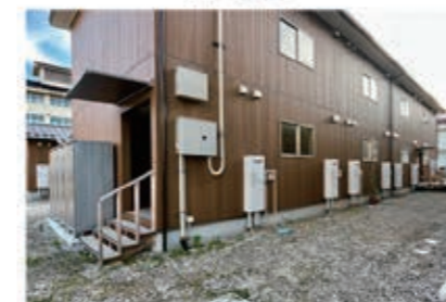
北側廊下への入り口
