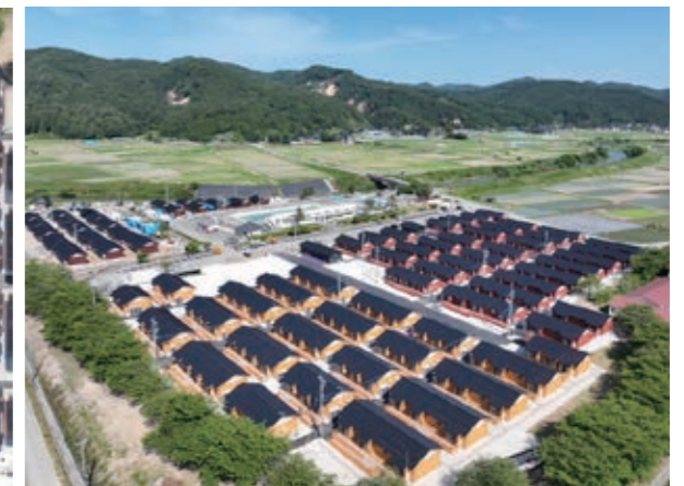
写真2 輪島市町野グラウンド仮設団地
