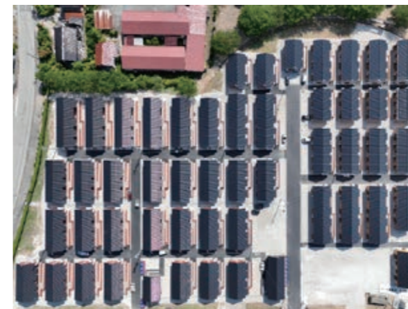
写真1 輪島市町野グラウンド仮設団地
