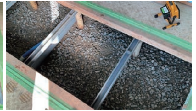
床下泥撤去後
