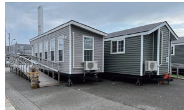
写真5 とぎ第1団地（トレーラーハウス）
