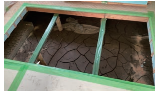
床下泥撤去前
