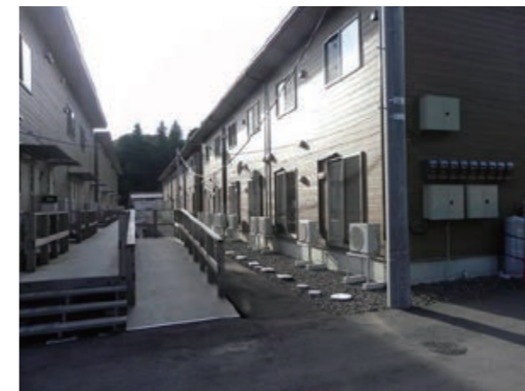
写真5 飯田町第1団地（公共下水道へ接続）
