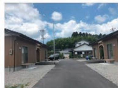
敷地内住戸間通路
