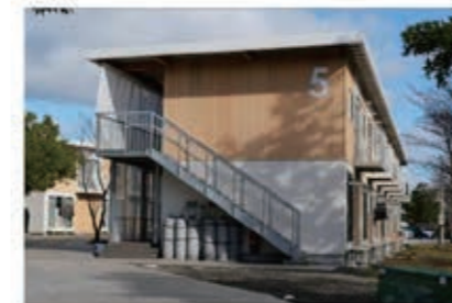
5号棟妻面(南西側)
