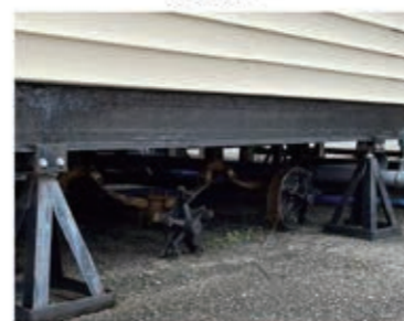
鋼製架台、車輪取り付け部
