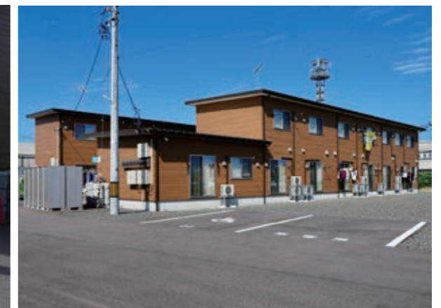
写真6 野々江町第8団地（公共下水道へ接続）
