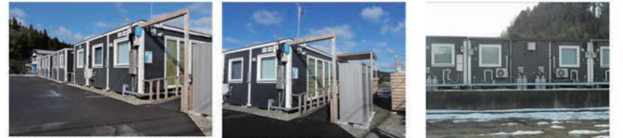
敷地出入口よりエントランス側(南西面)
