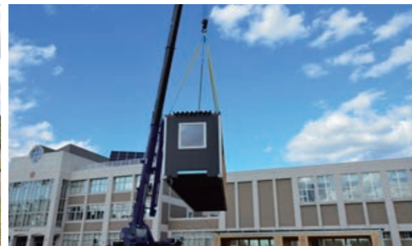
写真2 ムービングハウスが吊り下げられる様子
