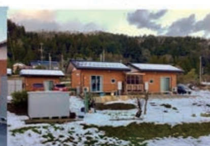
南側からの遠景
