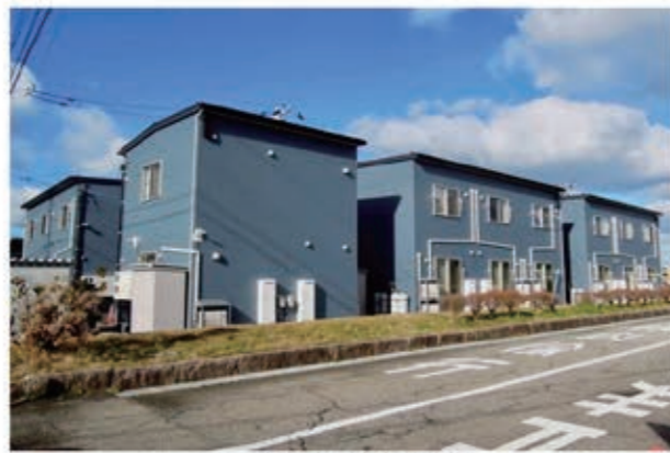
全景(内部階段 2階建て)
