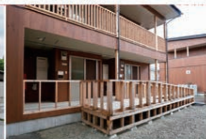
玄関側デッキと2階廊下手摺
