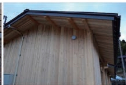
軒裏スギ板張り、母屋・桁あらわし
