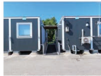
住戸間入口へのスロープ
