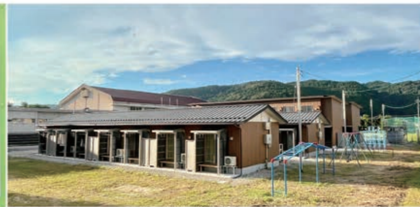
南東側より全景
