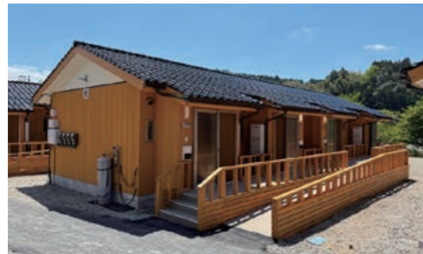
写真3 標準的な平屋タイプの外観
