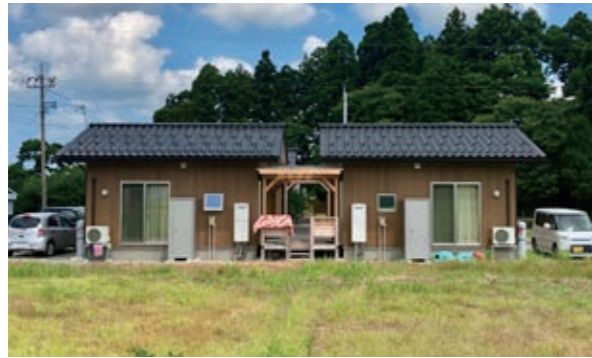
写真7 ふるさと回帰型の外観
