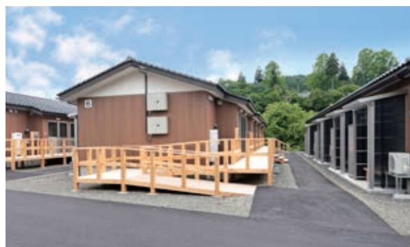
写真3 平屋(長屋型)の住棟
