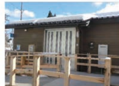
デッキ・玄関側(1号棟北側)
