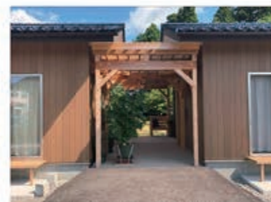
住戸間エリア 奥が出入口
