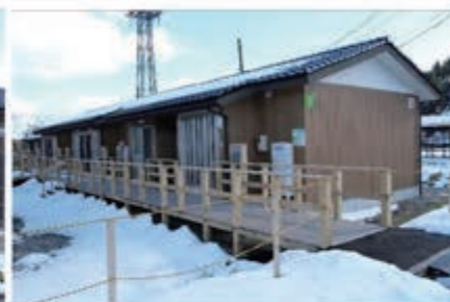
デッキ・玄関側(北側)
