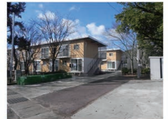
7-8号棟 東側外観
