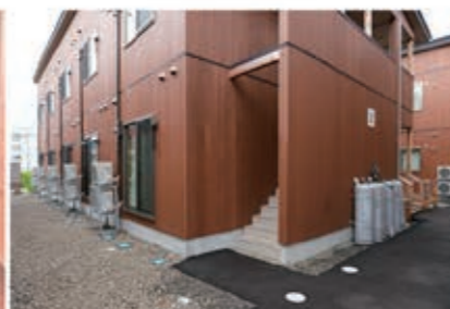
階段と設備機器
