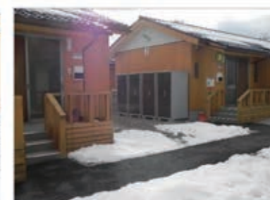
2号棟と3号棟の間・北側玄関
