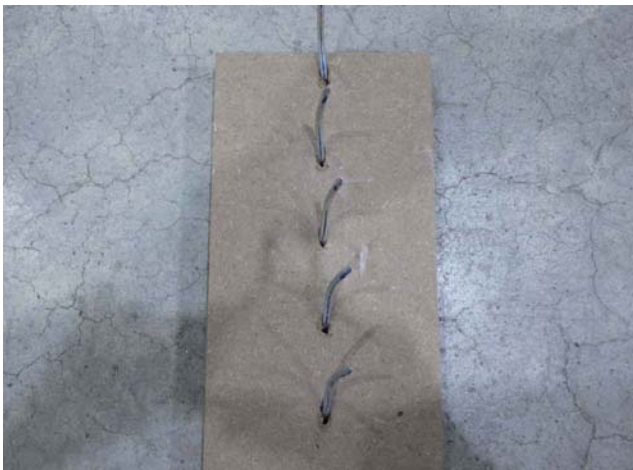
写真-108 「F_M_2/5_@50 解体後」
