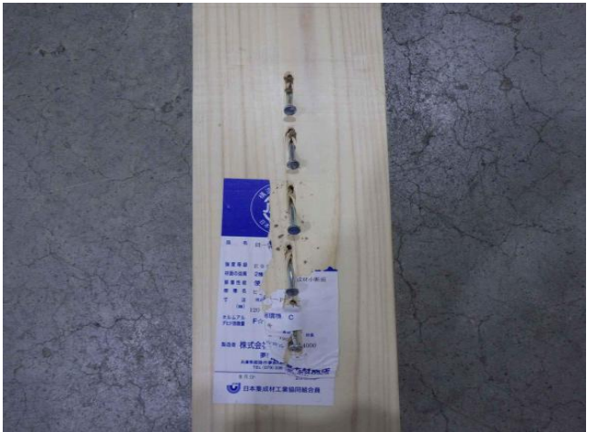
写真-69 「F_M_5_@40 解体後」
