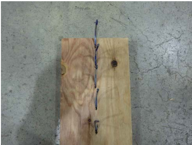
写真-104 「F_Ws_2/5_@40 解体後」
