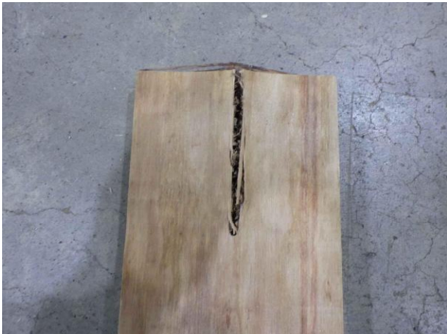
写真-56 「F_Ws_2_@20 解体後」
