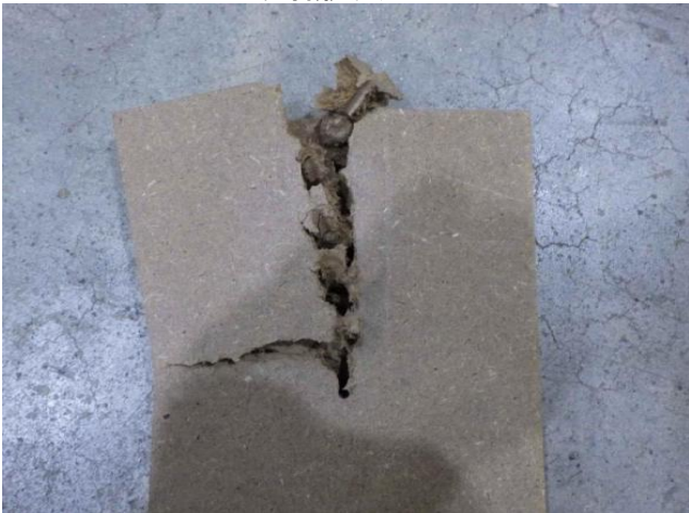
写真-84 「F_M_2_@20 解体後」
