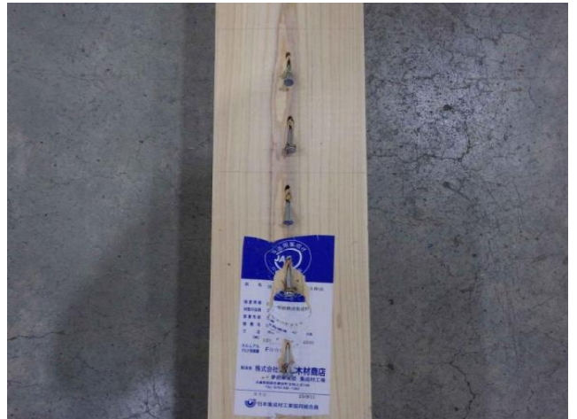
写真-53 「F_Ws_2_@60 解体後」
