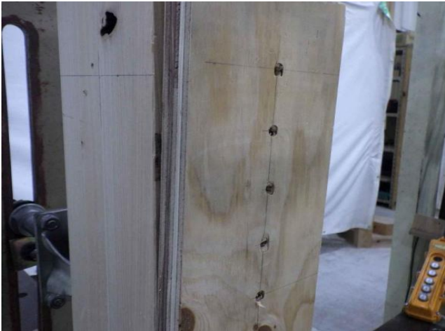
写真-38 「F_Ws_5_@40 試験終了後」
