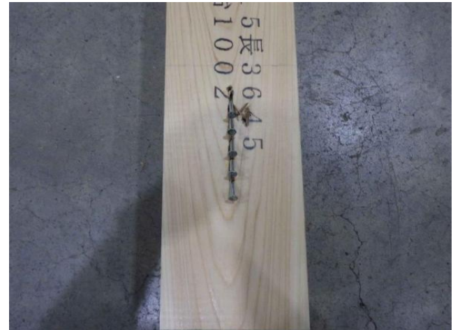
写真-57 「F_Ws_2_@20 解体後」
