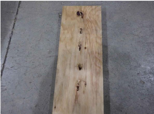
写真-32 「F_Ws_5_@60 解体後」
