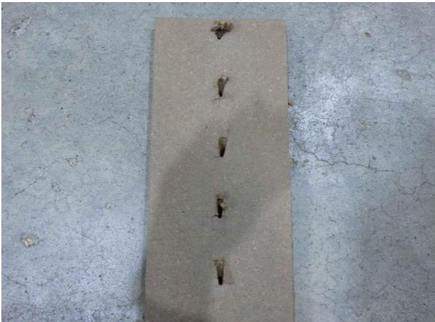
写真-80 「F_M_2_@60 解体後」
