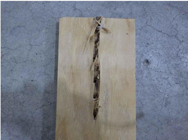
写真-16 「F_Wk_5_@30 解体後」
