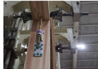
くぎの引抜け
