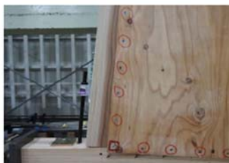
くぎの引抜け
