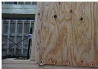
面材の縁切れ、くぎの引抜け
