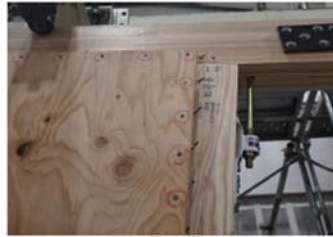
くぎの引抜け
