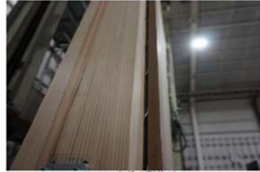
くぎの引抜け
