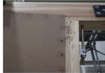
くぎの引抜け
