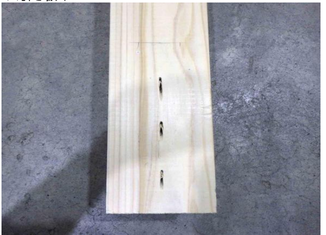
写真-25 「C_H_@60 解体後」
