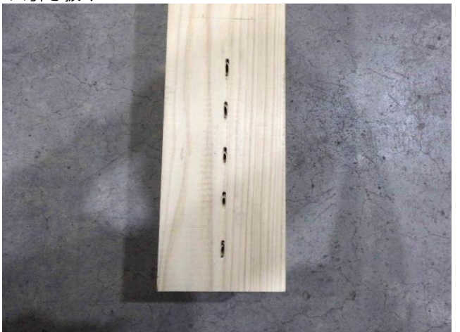
写真-17 「C_H_@50 解体後」
